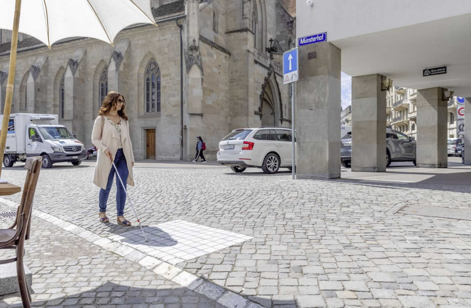
Das Aufmerksamkeitsfeld im Strassenbelag wird nicht nur vom weissen Stock wegen des Materialwechsels ertastet. Betroffene mit geringer Sehkraft erkennen die hellere Markierung als Orientierungshilfe, in diesem Fall, dass links abgebogen werden muss.
