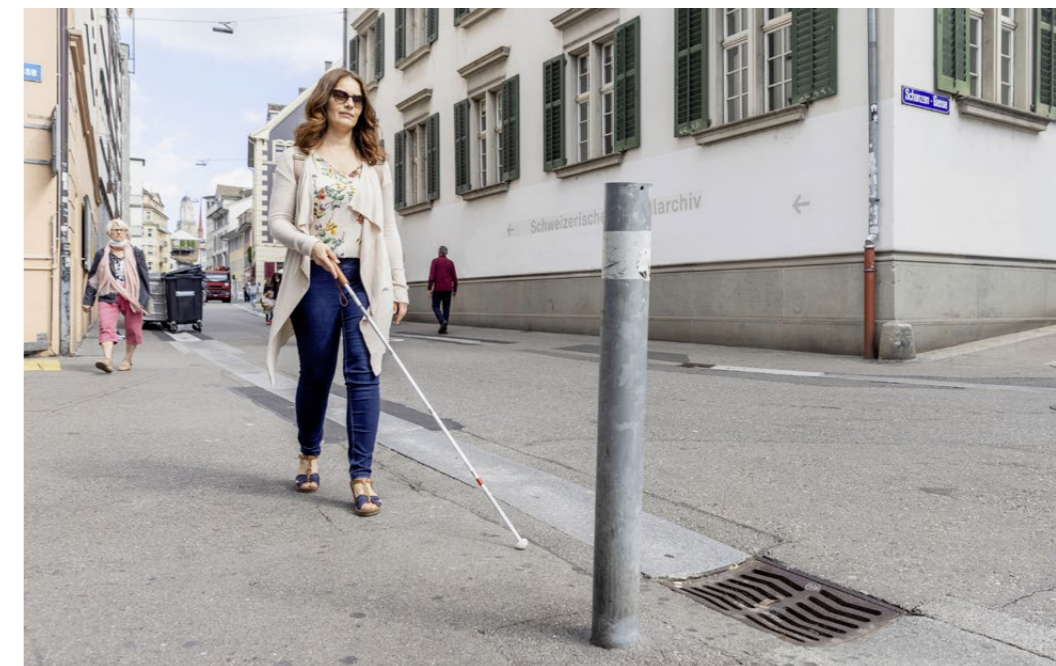
Die helle Markierung auf dem Pfosten weist Betroffenen mit minimaler Sehkraft auf ein Hindernis hin, noch bevor sie es mit dem weissen Stock berühren.
