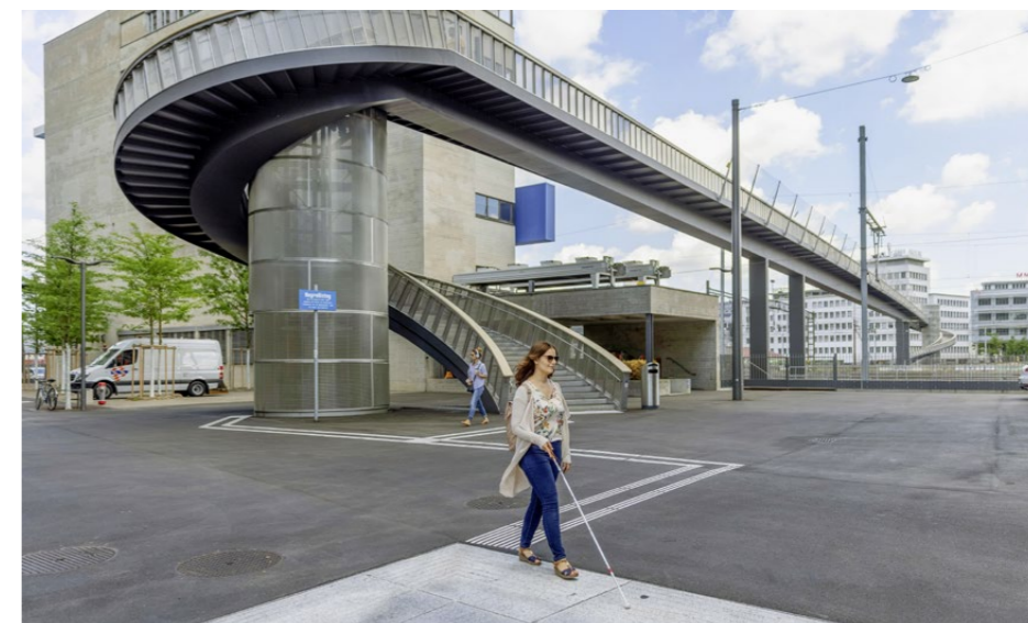
Das Belagsband ermöglicht eine sichere und direkte Verbindung zwischen und an öffentlichen Orten wie beim Überqueren einer Brücke oder auf dem Weg zum Bahnhof.
