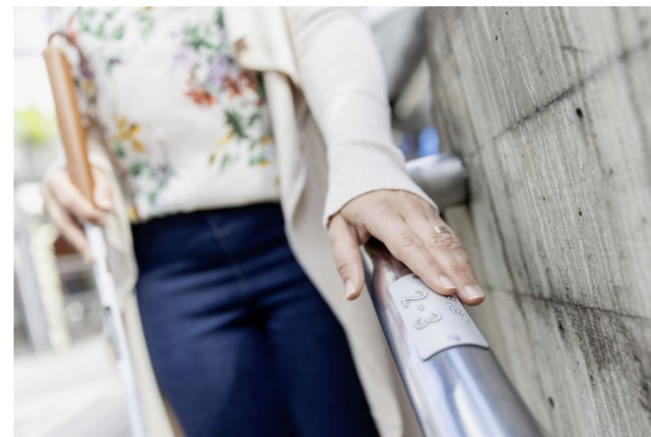
Brailleschrift auf dem Handlauf zum Perron verhindert das Warten auf dem falschen Bahnsteig.
