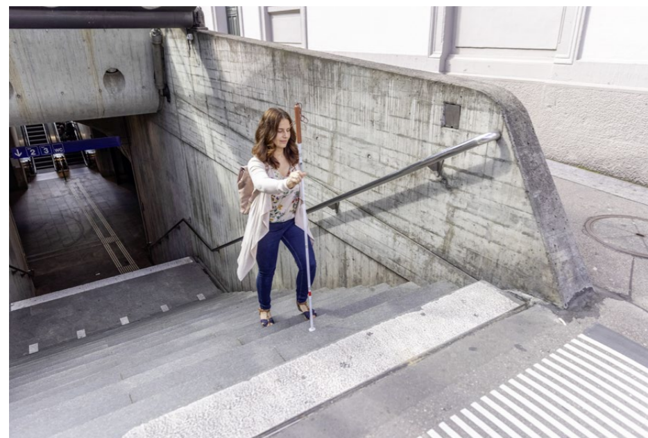
Der letzte Treppenabsatz ist sichtbar heller gekennzeichnet und gibt Auskunft zur letzten Stufe. In entgegengesetzter Richtung ist der gesteierte Belag ein Hinweis auf die Gefahrenquelle.
