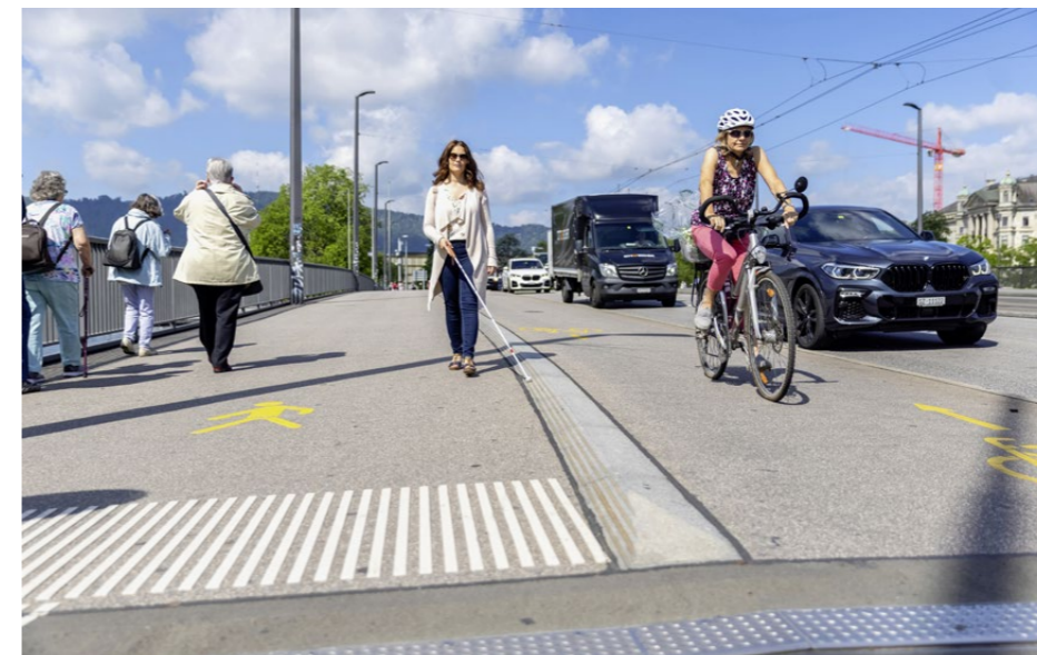
Die hellere, erhobene Abgrenzung am Trottoir dient als Leitlinie, die mit dem weissen Stock abgefahren werden kann. Das gestreifte Aufmerksamkeitsfeld weist auf eine bevorstehende Gefahr hin.
