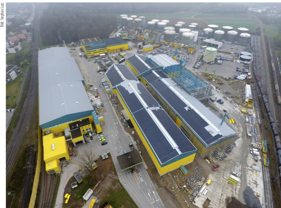
Das rund 20 000 Quadratmeter grosse Zentrum «EbiMIK» während der Bauphase im Frühjahr: Auf dem Dach wurde eine Photovoltaikanlage mit einer Leistung von zwei Megawatt installiert.
