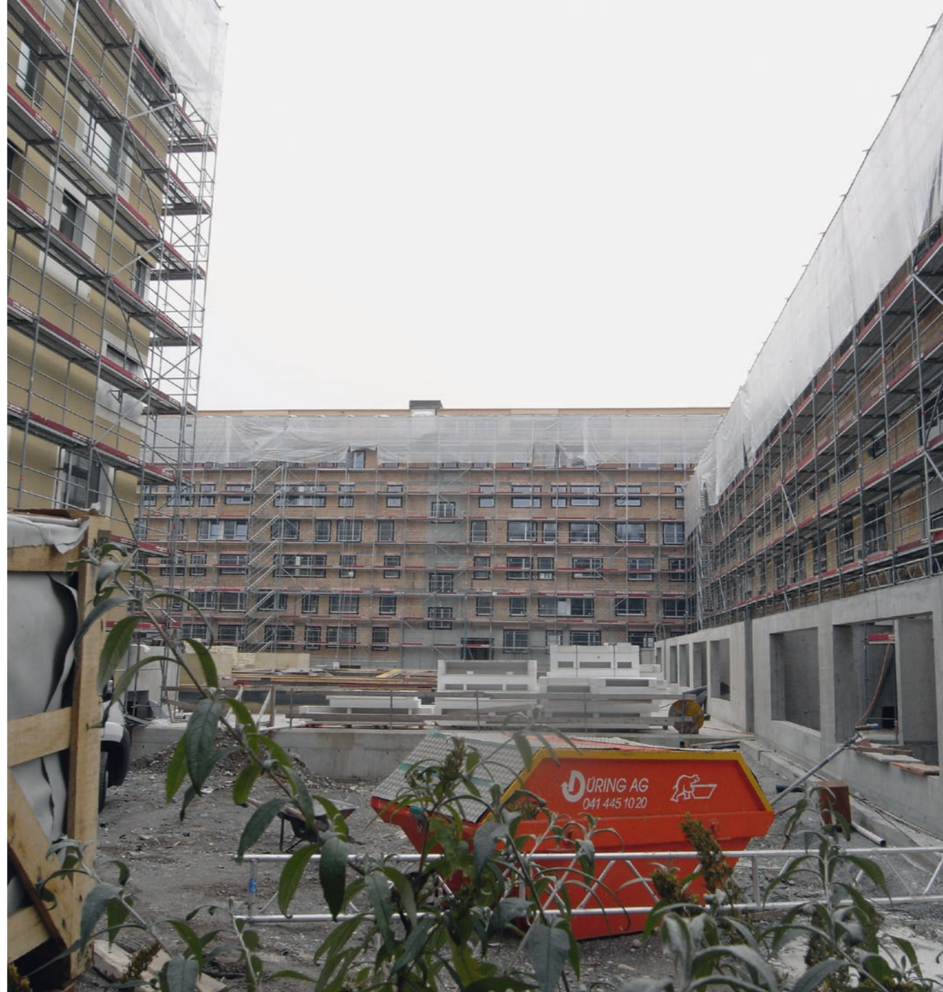
Ab dem neuen Jahr soll der Boom des Wohnbaus ausklingen. Das Bild zeigt eine weitere Baustelle im neuen Luzerner Quartier Tribsebenstadt.
