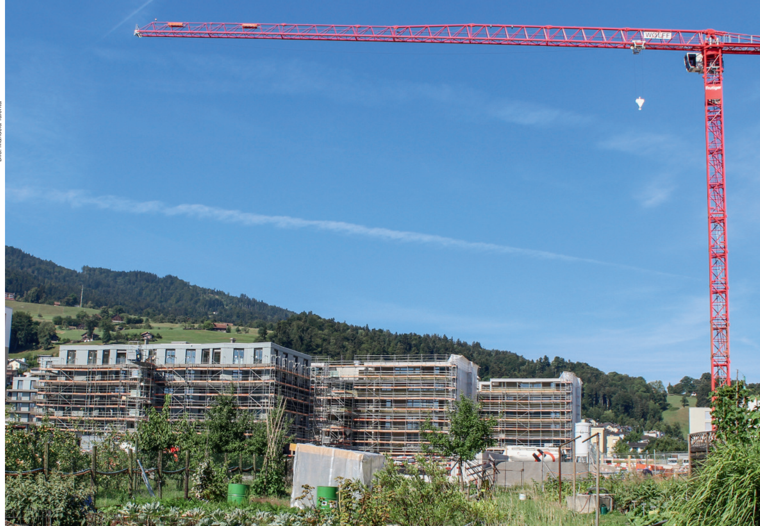
Im Gebiet Schlund in Kriens wird mit der Überbauung Schweighof das erste 2000-Watt-Areal der Zentralschweiz realisiert.
