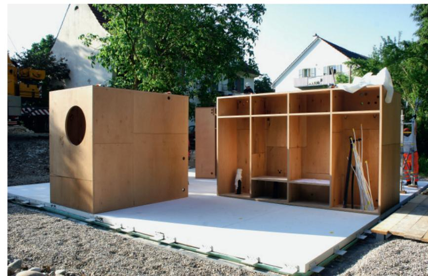
Auf der Bodenplatte werden zunächst die vier Kernelemente des Hauses montiert. Sie haben neben der technischen auch eine statisch tragende Funktion. Die Struktur aus Buchenholz-Mehrschichtplatten nimmt unter anderem die Bäder und Einbauschränke auf. Zudem wird in ihnen die komplette Technik integriert.
