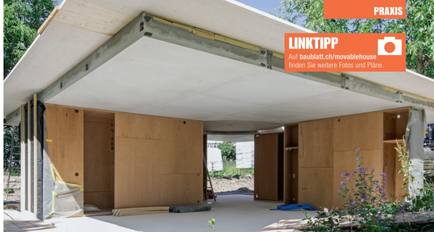
Die vorgefertigten Dach-Betonelemente sind aus Weisszement mit einem Zuschlag von Carrara-Marmor gefertigt. Die Elemente wiegen 1,5 bis 4,8 Tonnen.
