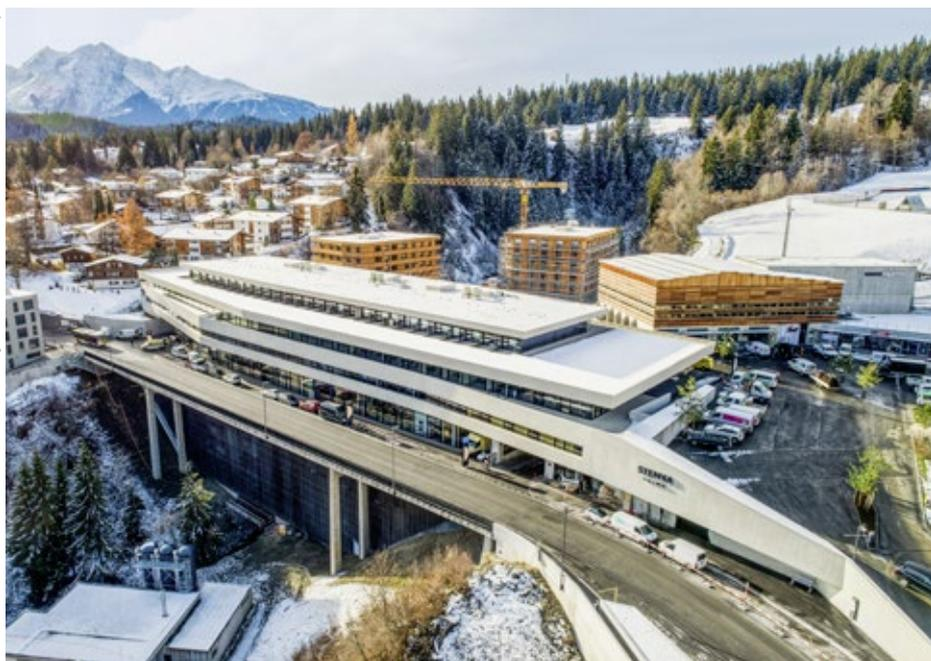
Das Hauptgebäude wurde als brückenartige Verbindung über die Stennaschlucht erstellt.
