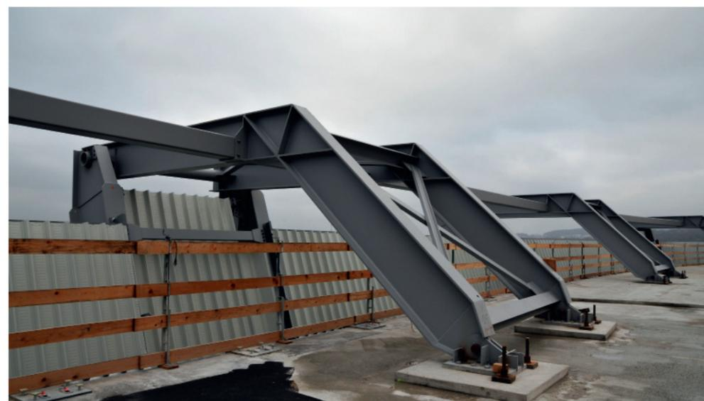
Solche sechs Tonnen schwere Galgen leiten die Windlast der Schutzwand ins Gebäude ab; mit Hilfe von zehn Meter langen 40er-Stahlstangen.
