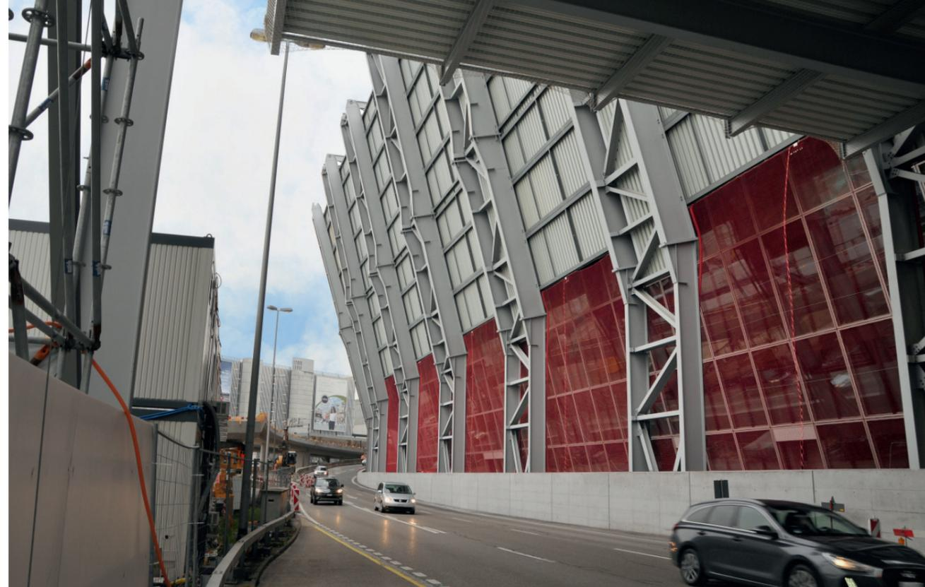
Die Kantonsstrasse rund um den Flughafen muss oft ein hohes Verkehrsaufkommen bewältigen. Die bis zu 13,5 Meter weit auskragende Schutzwand von «The Circle» schützt die darunter liegenden Fahrspuren. Für den Rückbau der Wand im Februar wird die Strasse jeweils nachts für fünf Stunden gesperrt.
