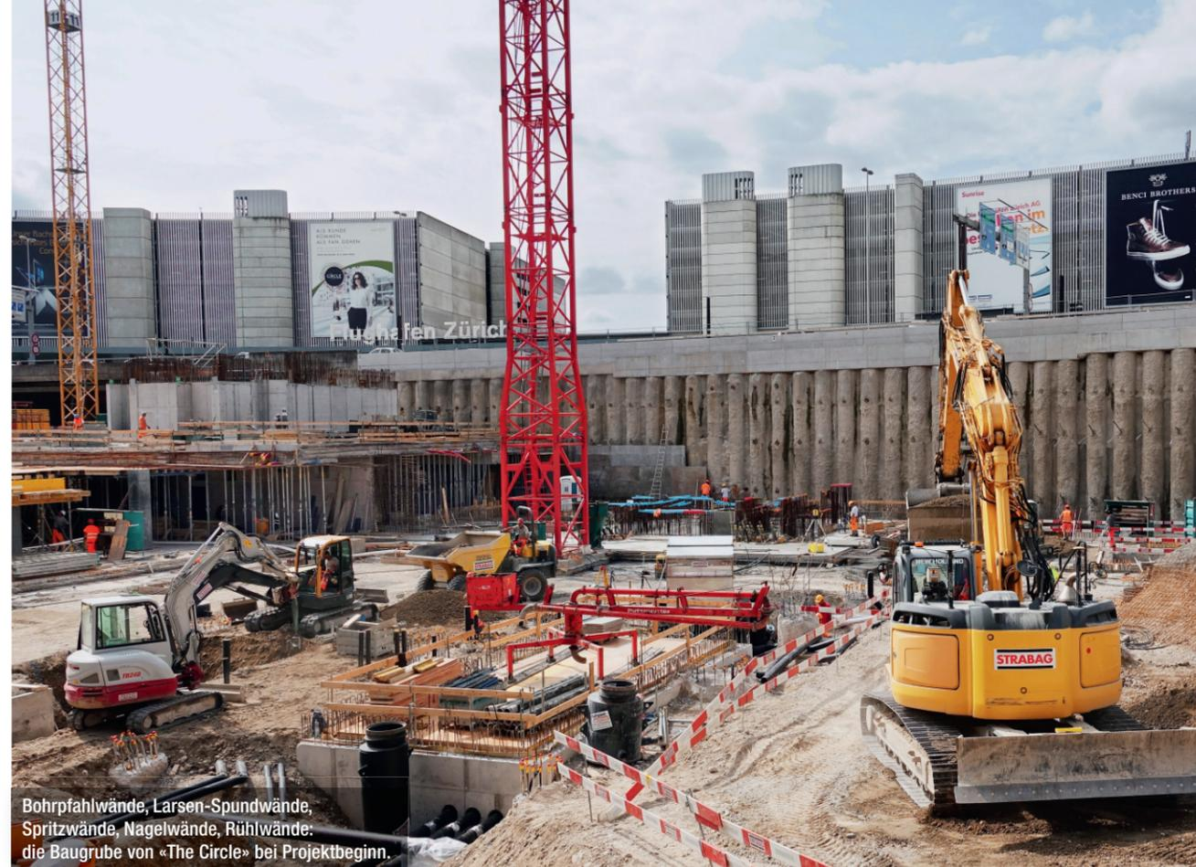
Bohrpfahlwände, Larsen-Spundwände, Spritzwände, Nagelwände, Rühlwände: die Baugrube von «The Circle» bei Projektbeginn.
