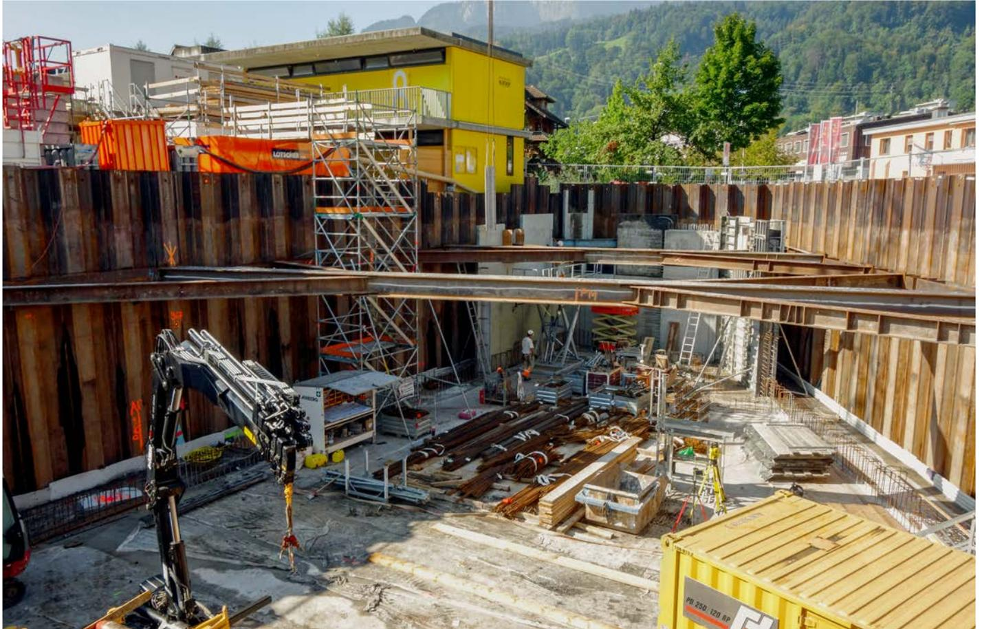
Wegen des instabilen Untergrunds kommt der Baugrubensicherung in Horw eine entscheidende Rolle zu.
