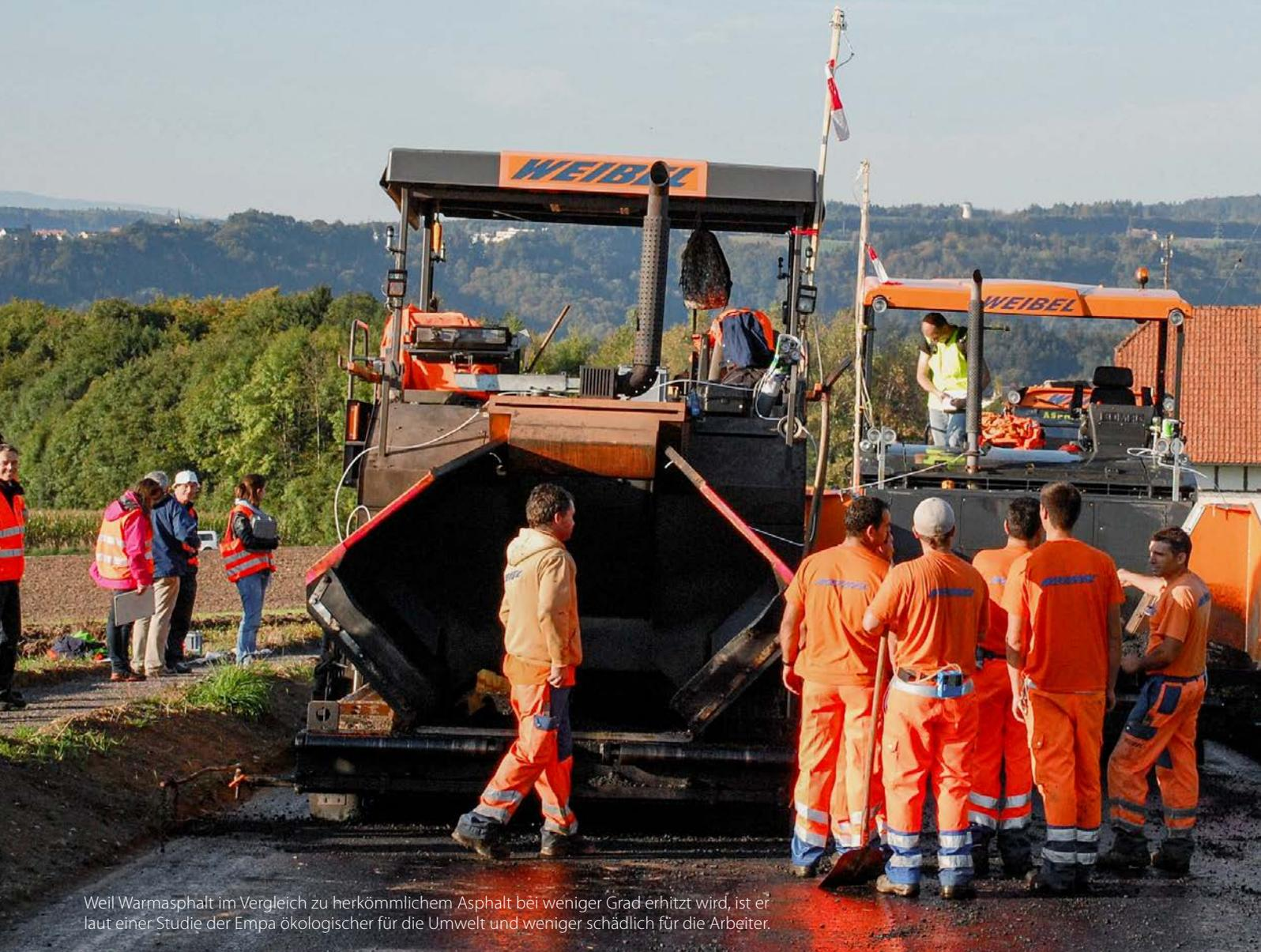
Weil Warmasphalt im Vergleich zu herkömmlichem Asphalt bei weniger Grad erhitzt wird, ist er laut einer Studie der Empa ökologischer für die Umwelt und weniger schädlich für die Arbeiter.
