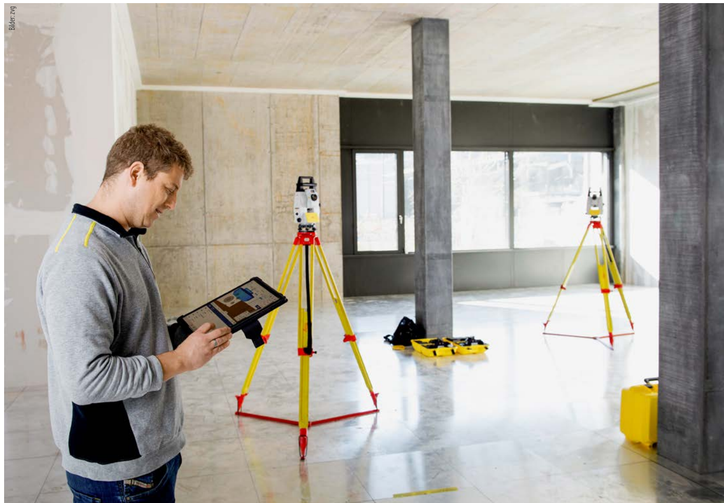
Die Totalstationen dienen beim Bau des Innovationsparks Zentralschweiz quasi als hochpräzise Baulaser: Sie übertragen die Daten aus dem BIM-Modell auf die Wand.
