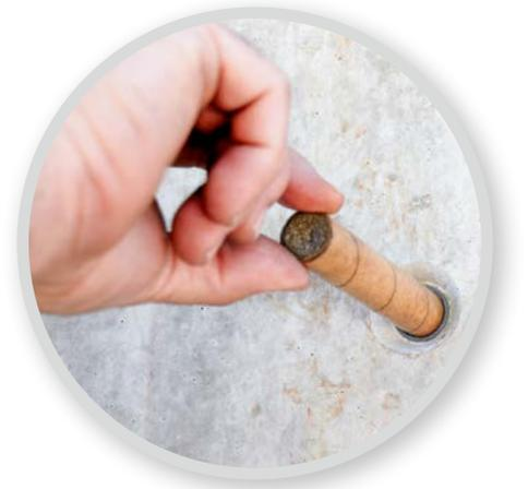
Der «BSS»-Schallschutzstopfen wird in das Bindeloch gesteckt und beidseitig mit Verschlusszapfen verschlossen.
