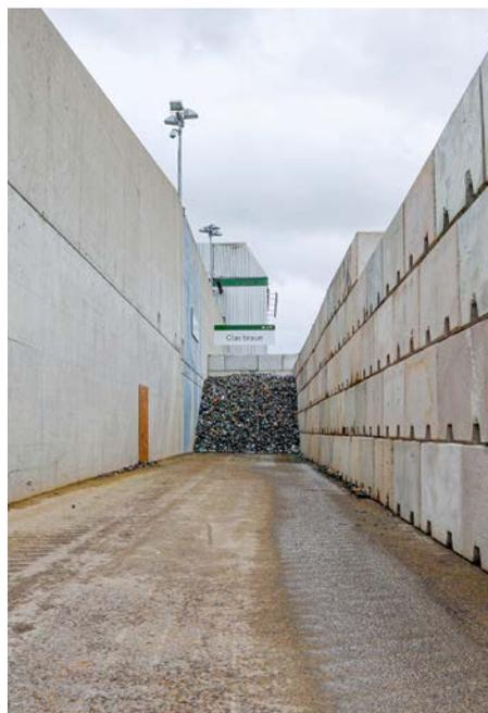
Warten aufs neue Material: Buchten aus Concretelementen dienen der Zwischenlagerung des Altglases vor dem Verlad.
