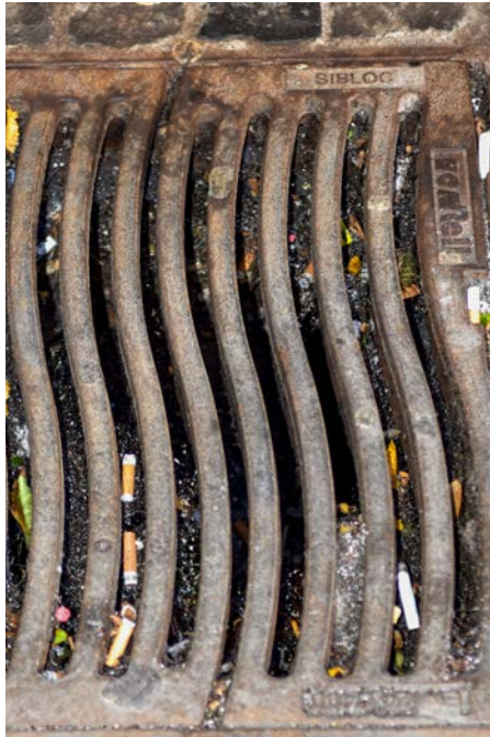
«Federklemmrost für Selbstarretierung» aus den 1990er-Jahren. Der Deckel aus Sphäroguss sitzt fest im Rahmen, scheppert nicht und wurde vor allem für Schweizer Autobahnen entwickelt. Er ist aber auch in Städten zu finden.
