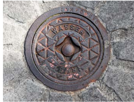
Eine Strassenkappe, die sitzt in der Regel über den Armaturen der Leitungen.
