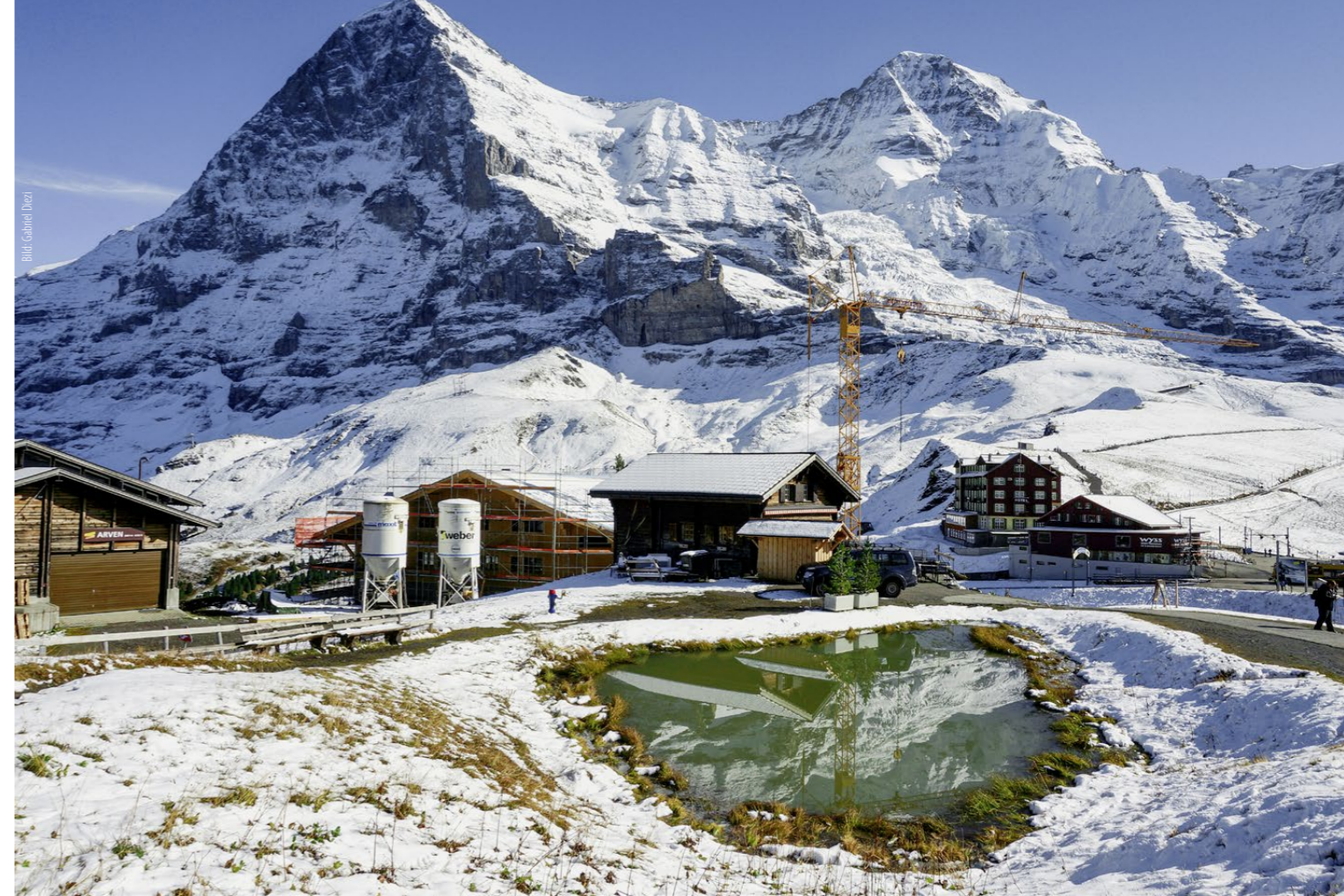
Baustelle oberhalb der Kleinen Scheidegg im Berner Oberland mit Blick auf die Eigernordwand und den Mönch.
