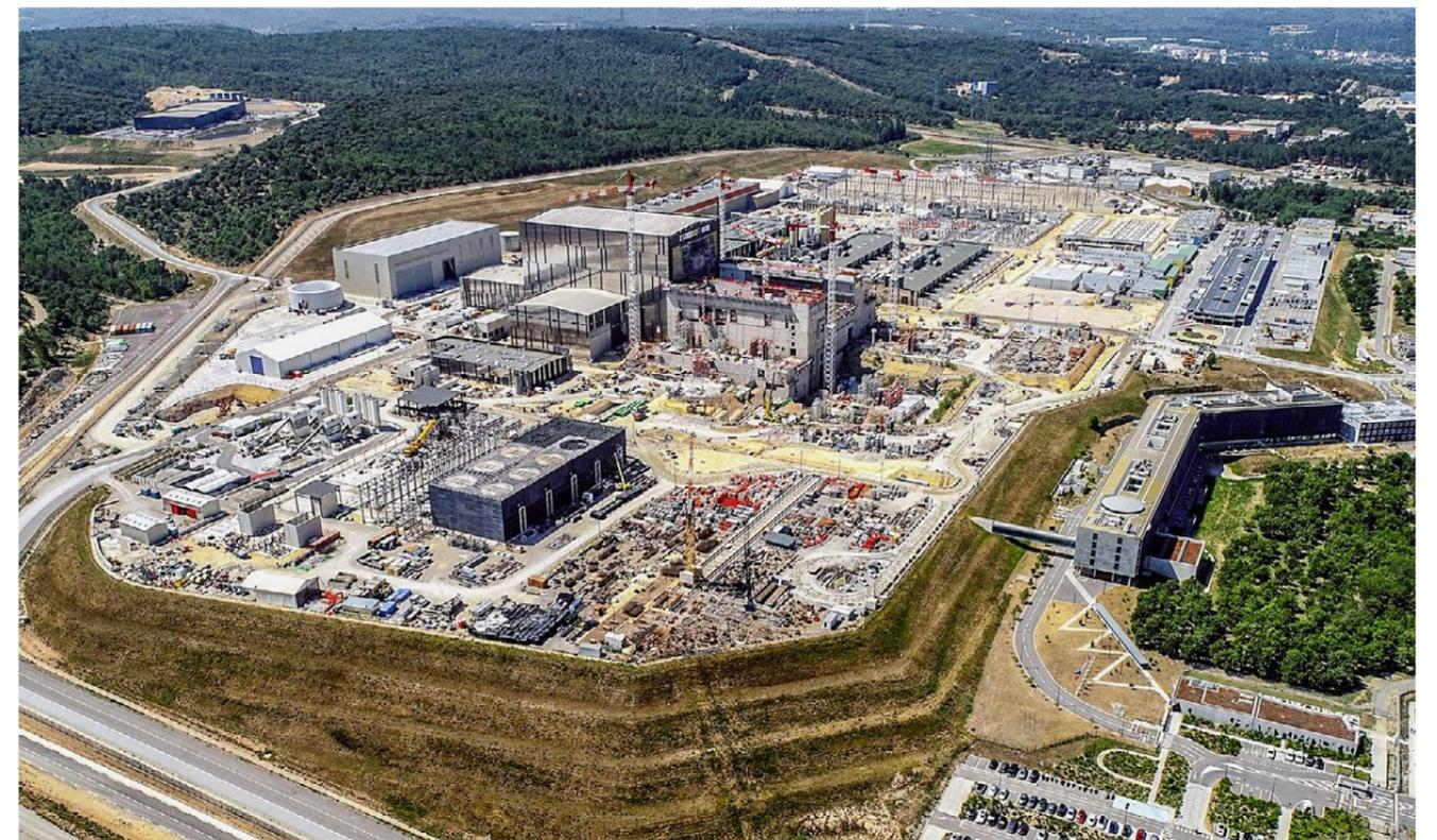
Stand Mitte 2019: 73 Prozent der Installationen inklusive der nötigen Verwaltungsgebäude sind fertig. Im Mittelpunkt der Tokamak-Komplex, der bereits fertig betoniert ist. In ihm wird der Fusions-Reaktor stehen. Der exakte Standort wurde nach der Beschaffenheit der Felsen im Untergrund gewählt.
