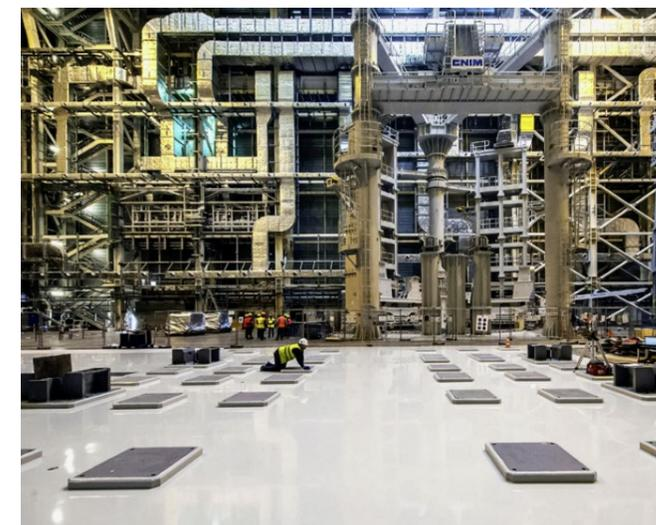
Von Oktober bis Dezember wurden 6500 Quadratmeter Boden der Montagehalle mit Epoxidharz beschichtet. Er hält auch den Schwerlasttransportern stand, die Teile für den Tokamak anliefern. Die Montage erfolgt unter möglichst reinen Bedingungen.
