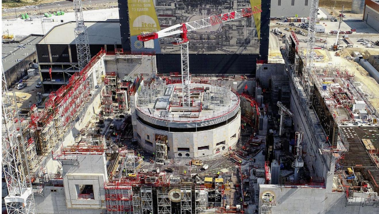
Der Reaktormantel des Tokamak ist nicht rund, sondern besteht aus 18 geraden Wänden oder Facetten. Die nukleartaugliche Betonstruktur um den Fusionsreaktor enthält 30000 Tonnen Baustahl und 150000 Kubikmeter Beton. Die dichtesten Eisengeflechte befinden sich im Fundament unter der Maschine und in der oberen Abdeckung.
