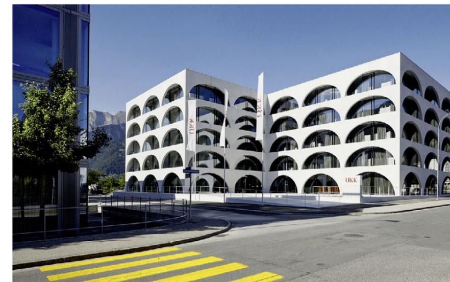
Der ÖKK-Hauptsitz in Landquart funktioniert nach dem LowEx-Prinzip: Tabs ermöglichen eine sparsame Heizung und Kühlung der Büros, indem die Speicherfähigkeit der Betonmasse genutzt wird.
