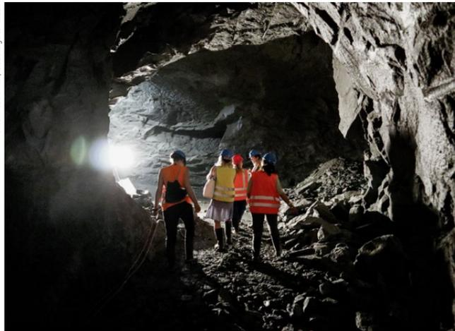
Führung durch den frisch ausgebrochenen Tunnel: Nur einige Details im Fels werden noch mittels Hochdruck-Wasserstrahl ausgearbeitet und hervorgehoben. Ausserdem wird der Boden rollstuhlgängig gemacht.
