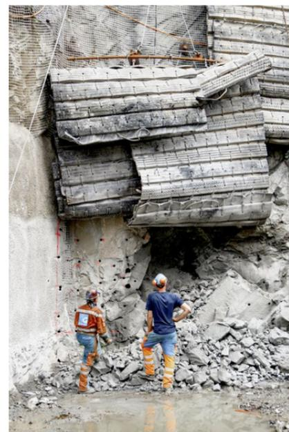
Eine der ersten Sprengungen: Dicke Matten dämpfen den Druck der Explosion. Rund um die Baustelle aufgestellte Messgeräte dokumentieren die verursachten Erschütterungen.
