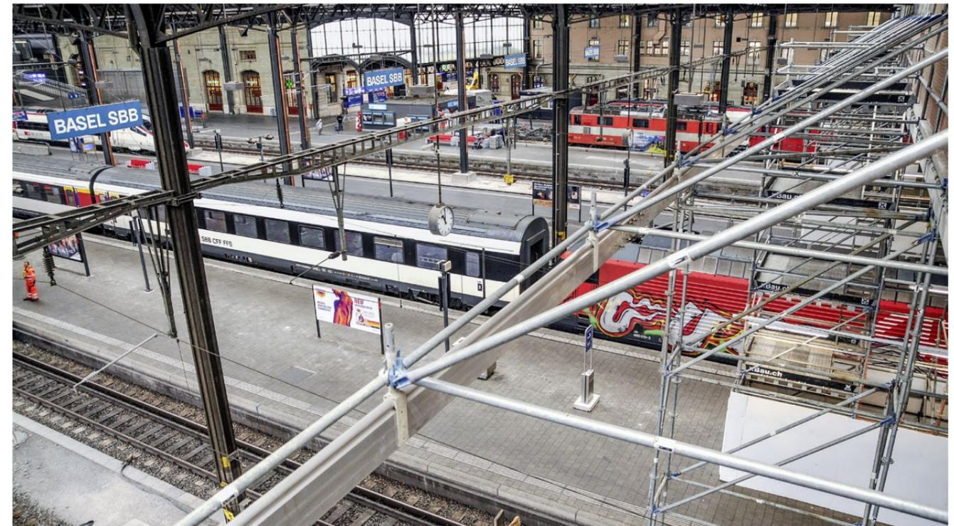
Blick hinunter auf die Gleise des Basler Bahnhofs SBB: Die Sanierungsarbeiten an der Perronhalle müssen unter laufendem Bahnbetrieb erfolgen und dürfen diesen nicht behindern oder beeinträchtigen – was die Aufgabe für die Verantwortlichen zusätzlich erschwert.
