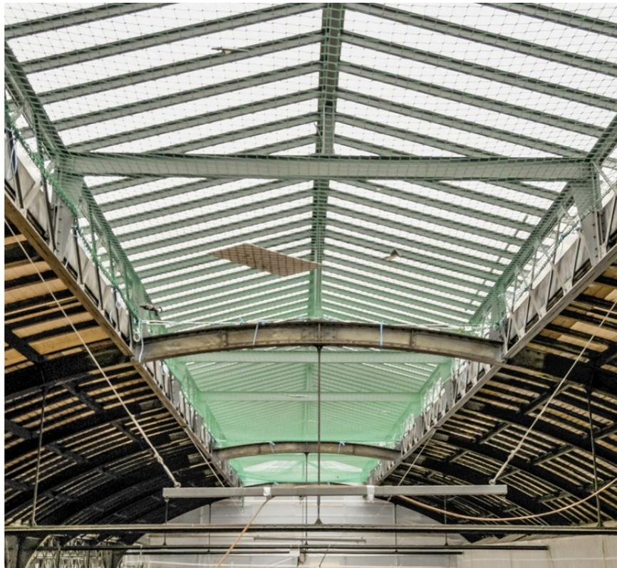
Blick unter ein fertig saniertes Dachteil: Wie die Stahlträger wurde auch das Holz mittels Sandstrahl gereinigt und danach mit einem neuen Schutzanstrich versehen, der 50 Jahre halten sollte.
