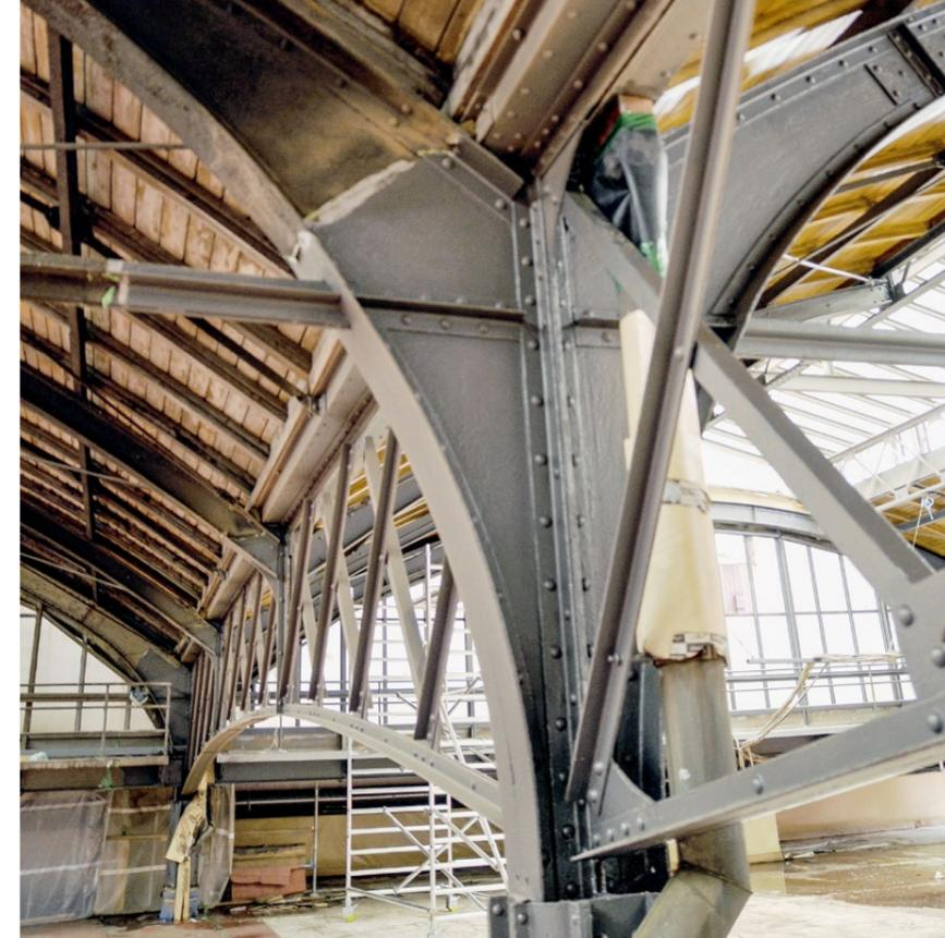
Ein Vorher-Nachher-Bild: Links Stahlträger und Holzdach im hundert Jahre alten Zustand; rechts dieselben Bauteile gereinigt und frisch mit Schutzanstrich versehen.
