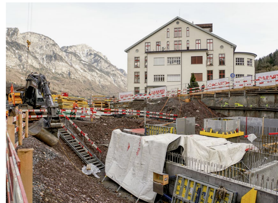
Gebaut wurde das Wasserkraftwerk Schils ursprünglich zur Stromversorgung der ehemaligen Spinnerei Spoerry, in deren Räumlichkeiten sich heute Gewerbebetriebe und Dienstleister finden.
