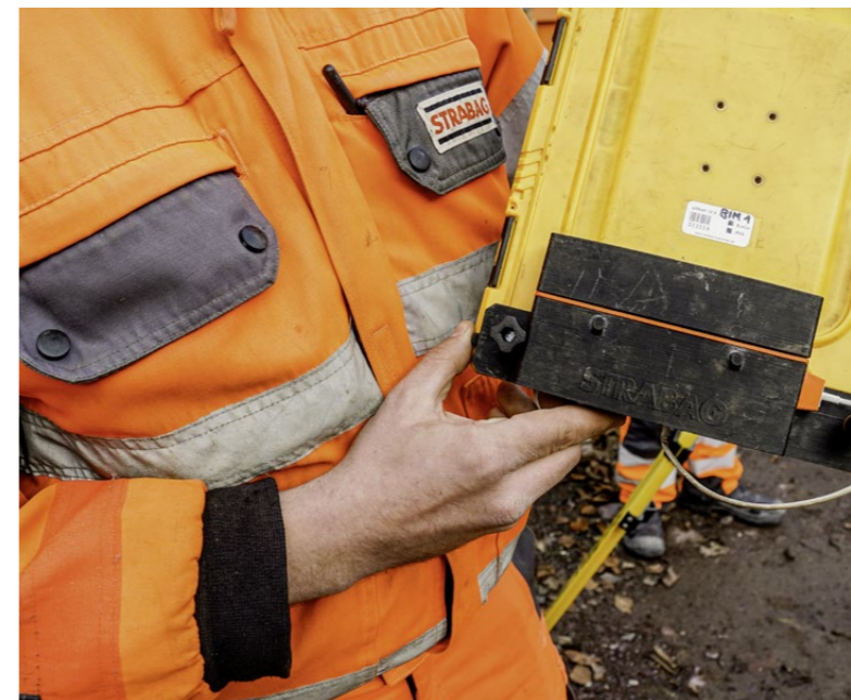
Eine zugekaufte Powerbank kombiniert mit einer Halterung aus dem 3-D-Drucker verlängert die Akkulaufzeit: So trotz man auf einer digitalisierten Winterbaustelle pragmatisch der Kälte.
