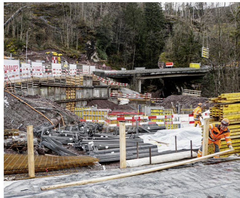
Dank der Online-Bestellung direkt aus dem Modell wird das Material just-in-time geliefert, was bei den knappen Platzverhältnissen rund um die Baugrube von Vorteil ist.
