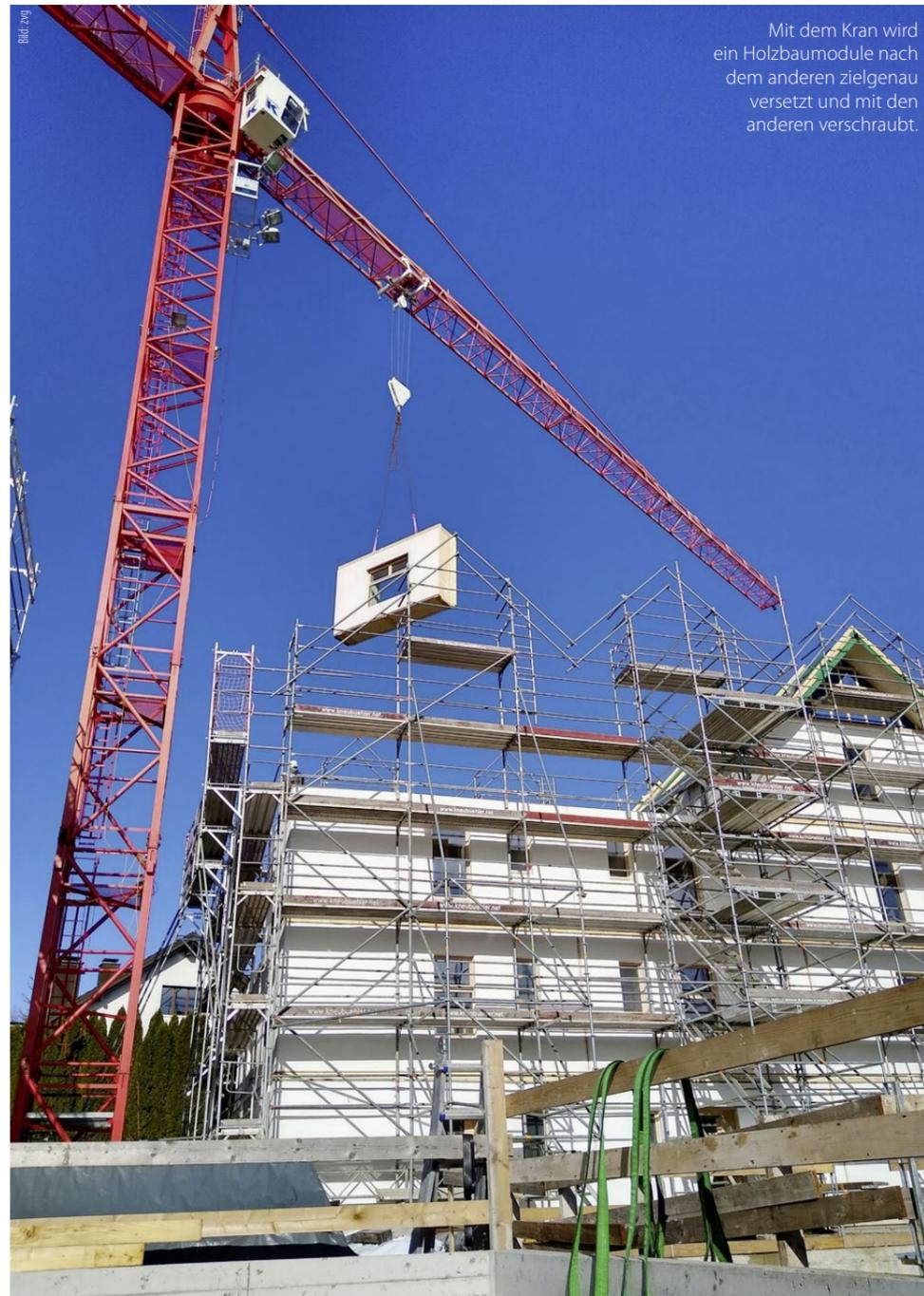
Mit dem Kran wird ein Holzbaumodul nach dem anderen zielgenau versetzt und mit den anderen verschraubt.
