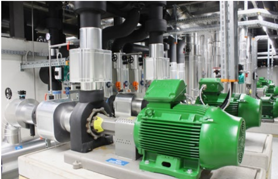
Nicht weniger als 50 Pumpen sind in der See-Energiezentrale Inseltiquai verbaut: Jene im Vordergrund dient zur Kühlung im Bahnhofsbereich.
