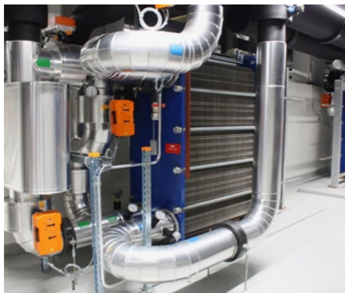
Zentrales Anlagenteil: Einer von insgesamt vier Platten-Wärmetauschern in der See-Energiezentrale Inseliquai.
