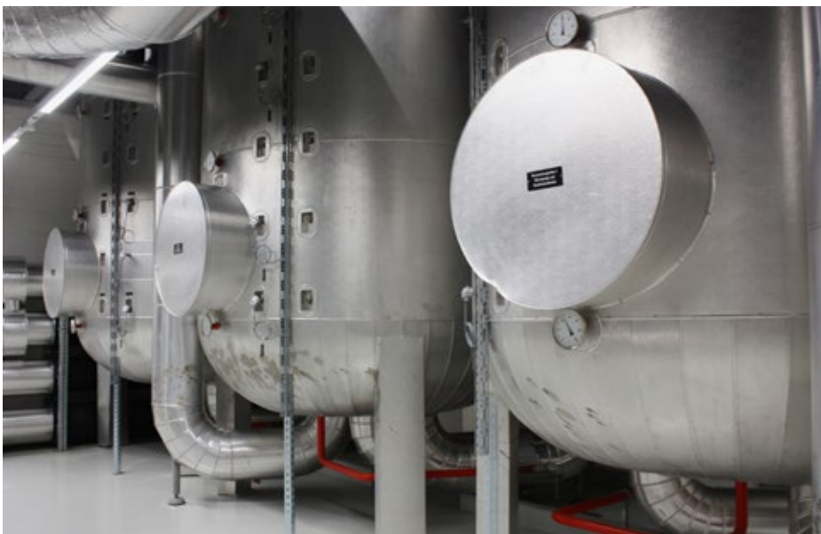
Diese drei Warmwasserspeicher zählen zu den wenigen Anlagenteilen, die schon in der ursprünglichen See-Energiezentrale in Luzern in Betrieb waren.
