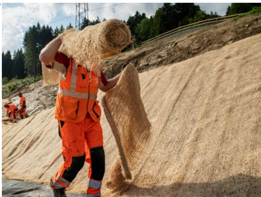
Mit körperlicher Arbeit ganz ohne Fitnesssabo die Muskeln stählen, wie hier beim Tragen einer Rolle mit Holzwoollyliess zum Schutz eines Hangs vor Erosion. Für so manche ist das ein gutes Argument für eine Berufslaufbahn auf dem Bau.
