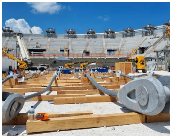
... Und so wurden sie im Sommer 2025 verbaut: Mit Durchmessern bis 140 Millimeter sollen sie Hurrikans standhalten.
