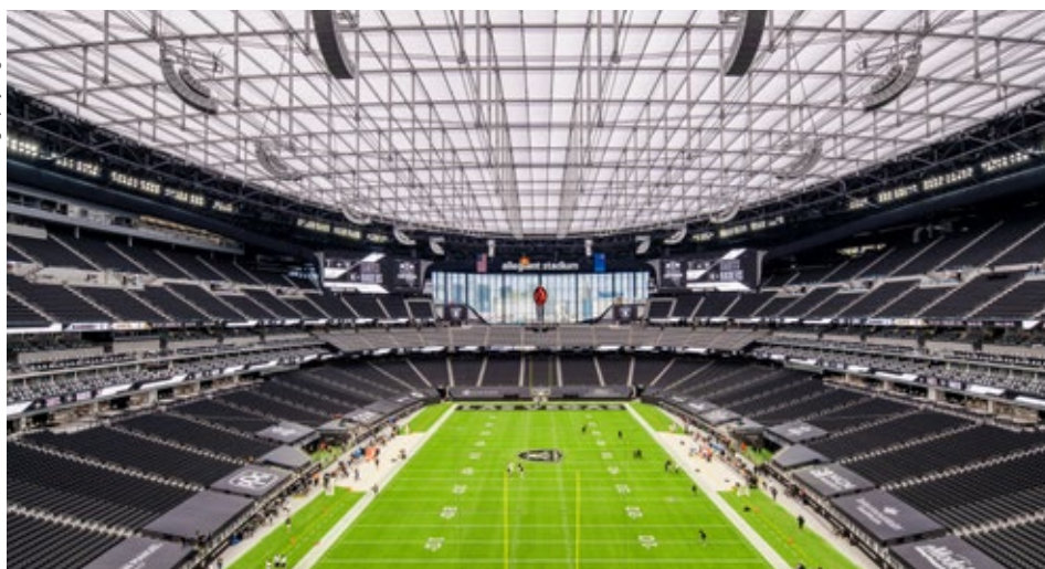
Auch hier sind Stahlseile der Fatzer AG aus Romanshorn verbaut: das Allegiant Stadium, die Heimarena des American-Football-Teams Las Vegas Raiders.
