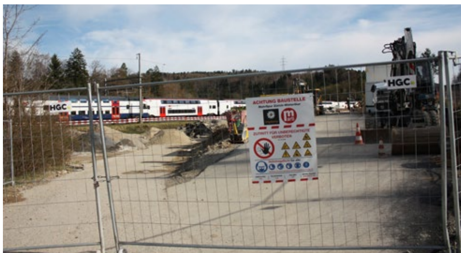
Weil die Arbeiten wie hier am Installationsplatz bei Winterthur neben der vielbefahrenen Bestandsstrecke erfolgen, ziehen bis zur Inbetriebnahme noch über elf Jahre ins Land.
