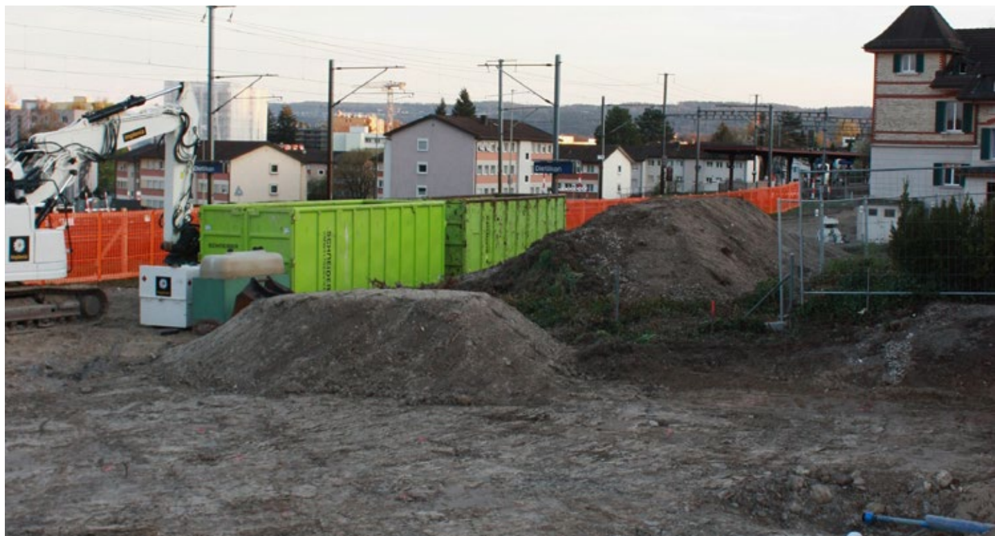
Östlich des Bahnhofs Dietlikon mussten zwei Häuser einem temporären Parkplatz weichen. In Zukunft wird hier das neue vierte Gleis einen Teil der Fläche einnehmen.
