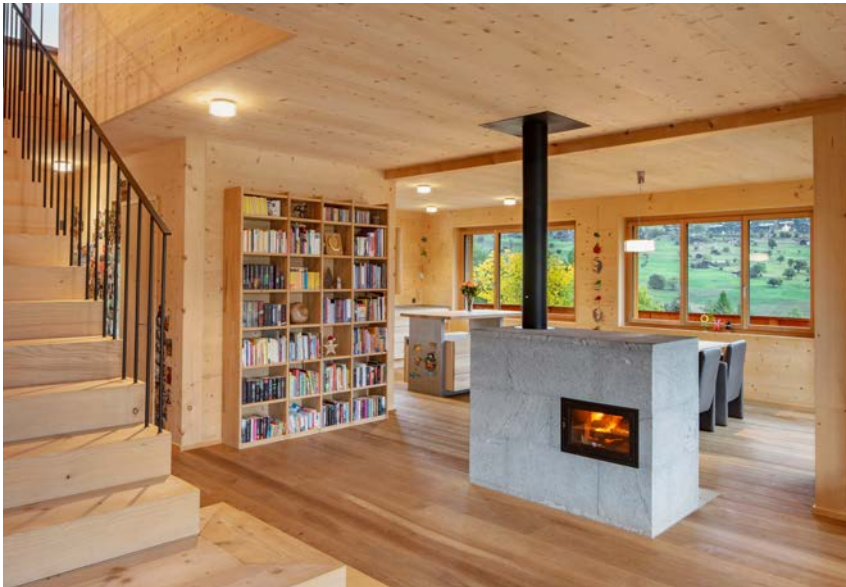
In Albrechts Mondhaus bestehen Wände und Decken aus mehreren Bretterlagen, zusammengehalten durch Holzdübel. Auf Leim und Chemie wird verzichtet.
