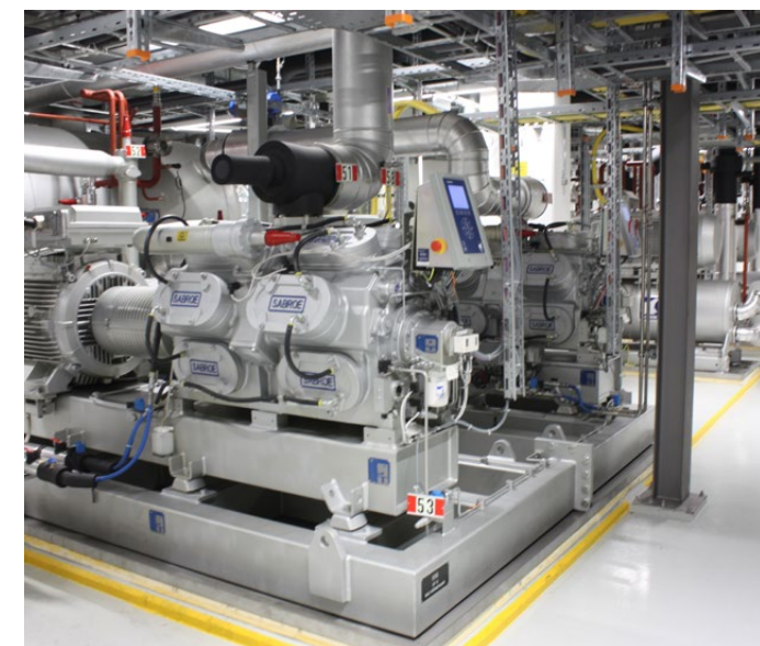
Das Herzstück der Anlage: der Wärmepumpen-Raum im dritten Untergeschoss.
