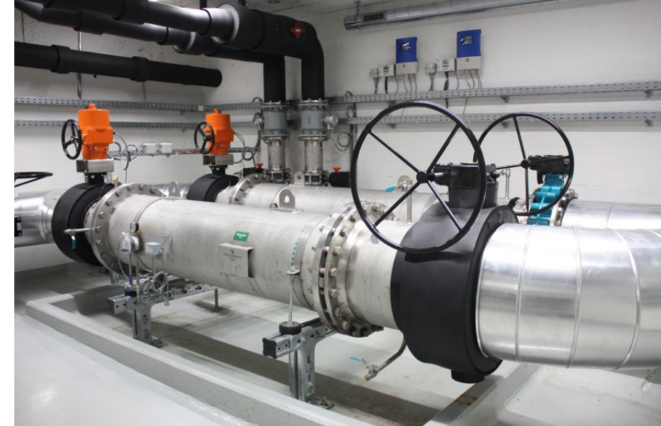
Ein Blick auf die zwei Seewasserfilter, die abwechselnd in Betrieb sind. Fällt einer unerwartet aus, wird der andere eingeschaltet, um den lückenlosen Fluss des Seewassers im Primärkreislauf sicherzustellen.
