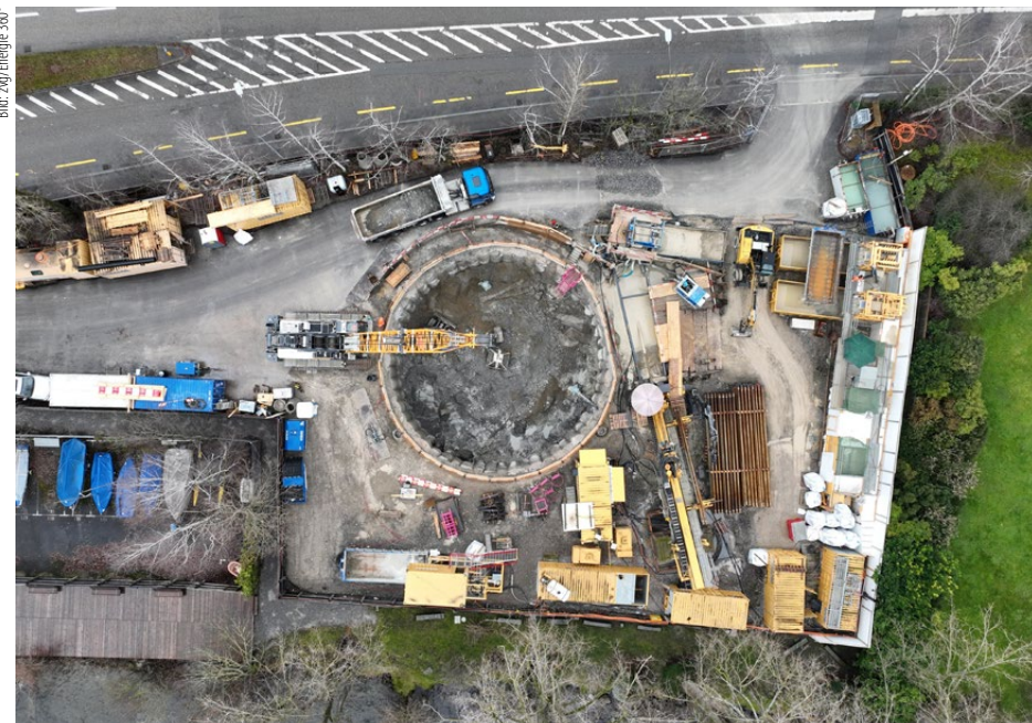
Hier entsteht auf fünf Stockwerken unter der Erde eine Energiezentrale: Bild vom Aushub der Seewasserzentrale in Zollikon von Anfang 2025.
