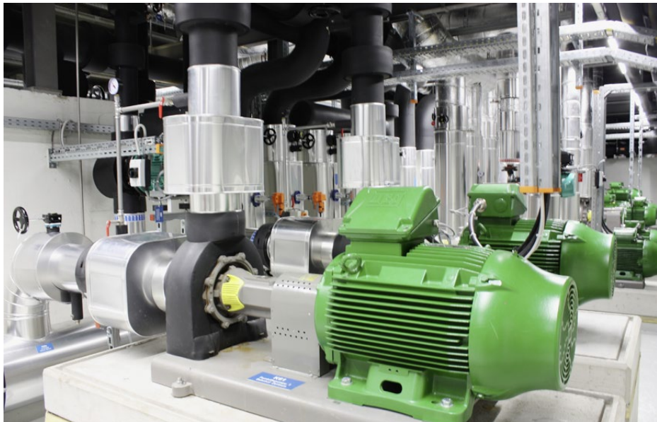
Nicht weniger als 50 Pumpen sind in der See-Energiezentrale Inslikwai verbaut: Jene im Vordergrund dient zur Kühlung im Bahnhofsbereich.
