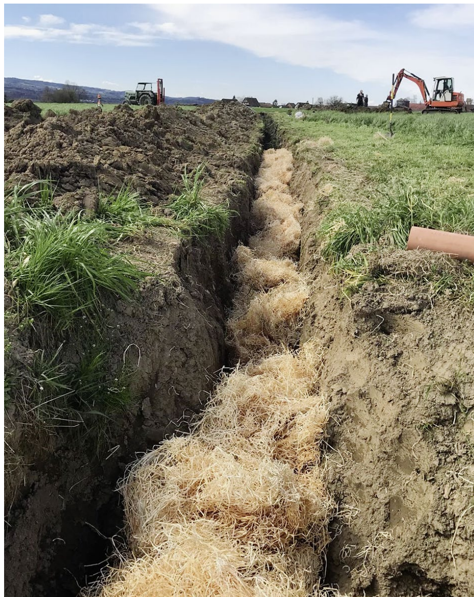
Einsatzfeld Landwirtschaft: Drainagen aus Holzwole beseitigen Staunässe und tragen so zu einer besseren Bodendurchlüftung und Nährstoffsituation sowie zu einem aktiveren Bodenleben bei.
