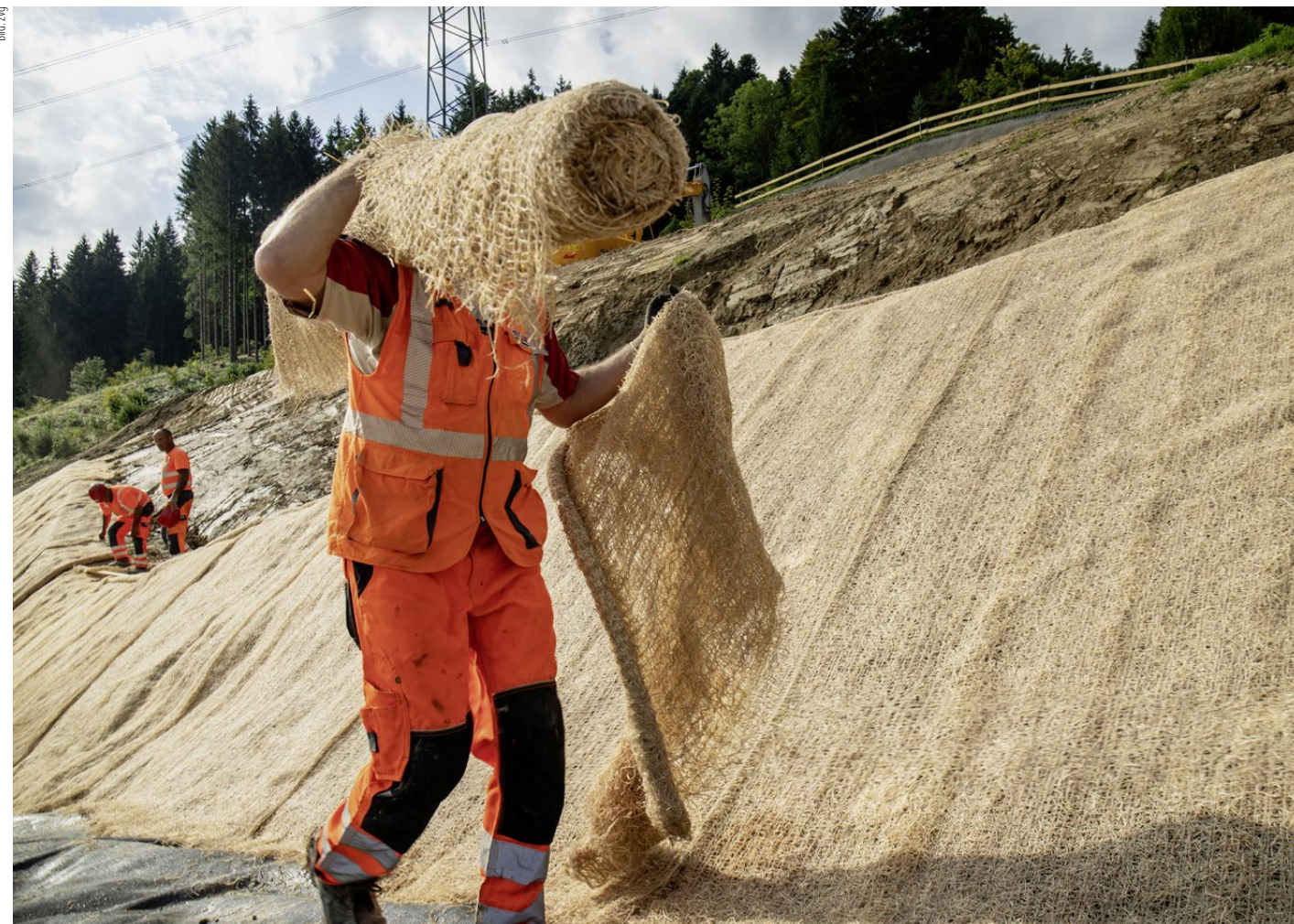
Holzwollvliese – nun vom Unternehmen Lindner Suisse mit Fäden aus Buchen hergestellt, statt mit importierter Jute oder Kokosfasern – schützen steile Stellen wie diese hier vor Erosion.
