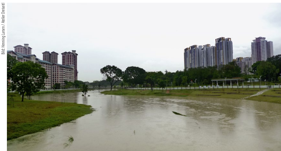
Bei Regenfällen füllt sich der Fluss Kallang, der durch den Bishan-Park in Singapur fliesst. Er ersetzt den einst hier verlaufenden Betonkanal, der in den siebziger Jahren gebaut worden war.
