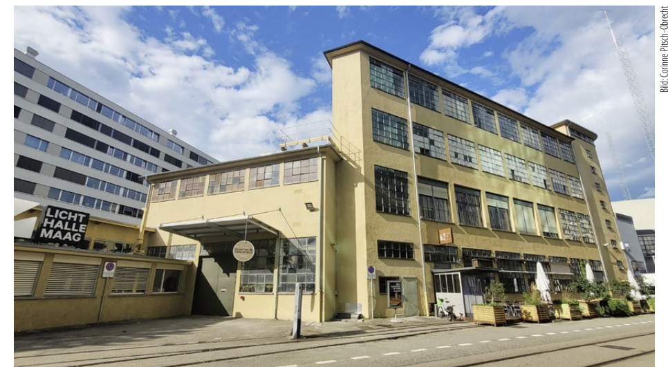
Das Gebäude K, welches in jedem Fall bestehen bleibt.
