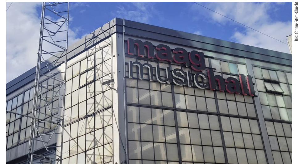
Der ikonische Schriftzug der Maag Music Hall. Deutlich zu sehen: Die Bauprofile des projektierten Baus.
