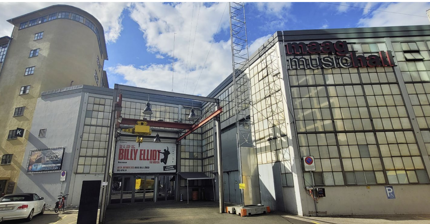
Das Ensemble, wie es hier zu sehen ist, ist akut bedroht: Einzig der gelbe Bau links im Bild soll bleiben dürfen. Der ganze Rest soll, wenn es nach dem Willen der SPS geht, abgebrochen werden.
