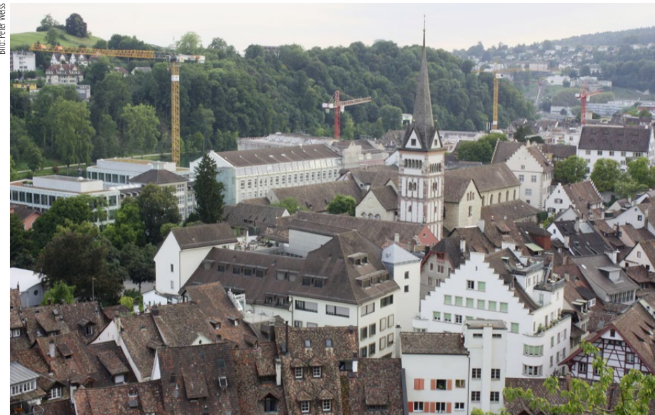
Rege Bautätigkeit im Schaffhauser Stadtkern: Links im Bild sind die Baukräne vom Umbau- und Sanierungsprojekt Kammgarnareal zu sehen, rechts jene am Wohnbauprojekt Silberhof.
