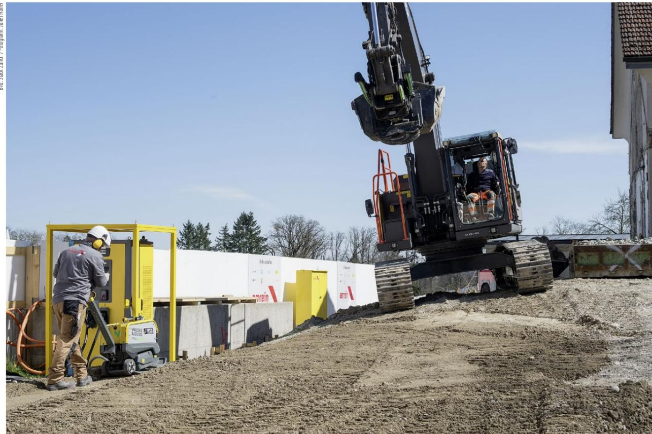
Ladestation statt Baustellentank: Bei der Sanierung einer Turnhalle in Zürich kommen nur elektrisch betriebene Baumaschinen und Geräte zum Einsatz.
