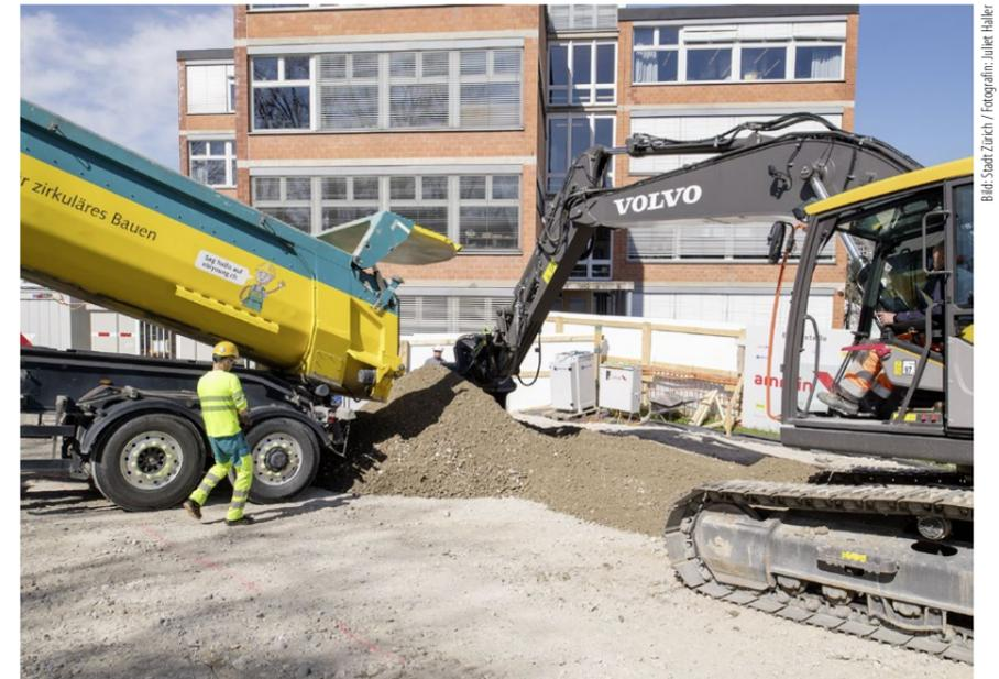
Der Raupenbagger nimmt Baumaterial vom E-Muldenkipper entgegen: In einigen Bereichen erwies sich die Beschaffung der elektrisch betriebenen Baumaschinen als aufwendig.
