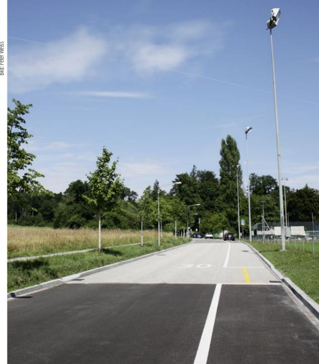
Flickenteppich mit System: Die 190 Meter lange Teststrecke in Zürich-Witikon mit dem dunklen Referenzbelag aus konventionellem Asphalt im Vordergrund.
