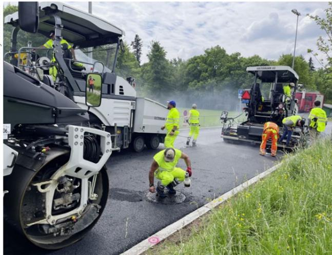
Einbau der kühlenden Strassenbeläge, wie hier in Zürich-Witikon: Das Auftragen der Deckschicht läuft gleich ab wie bei herkömmlichem Asphalt.
