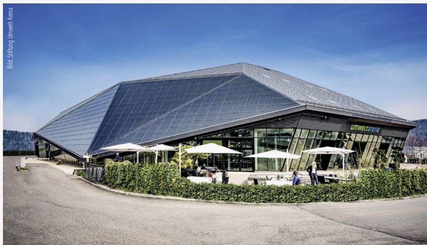
Eine Photovoltaik-Anlage umspannt die einzigartige Architektur des Gebäudes der Umwelt Stiftung Schweiz. Es produziert mehr Energie als für ihren Betrieb benötigt wird.
