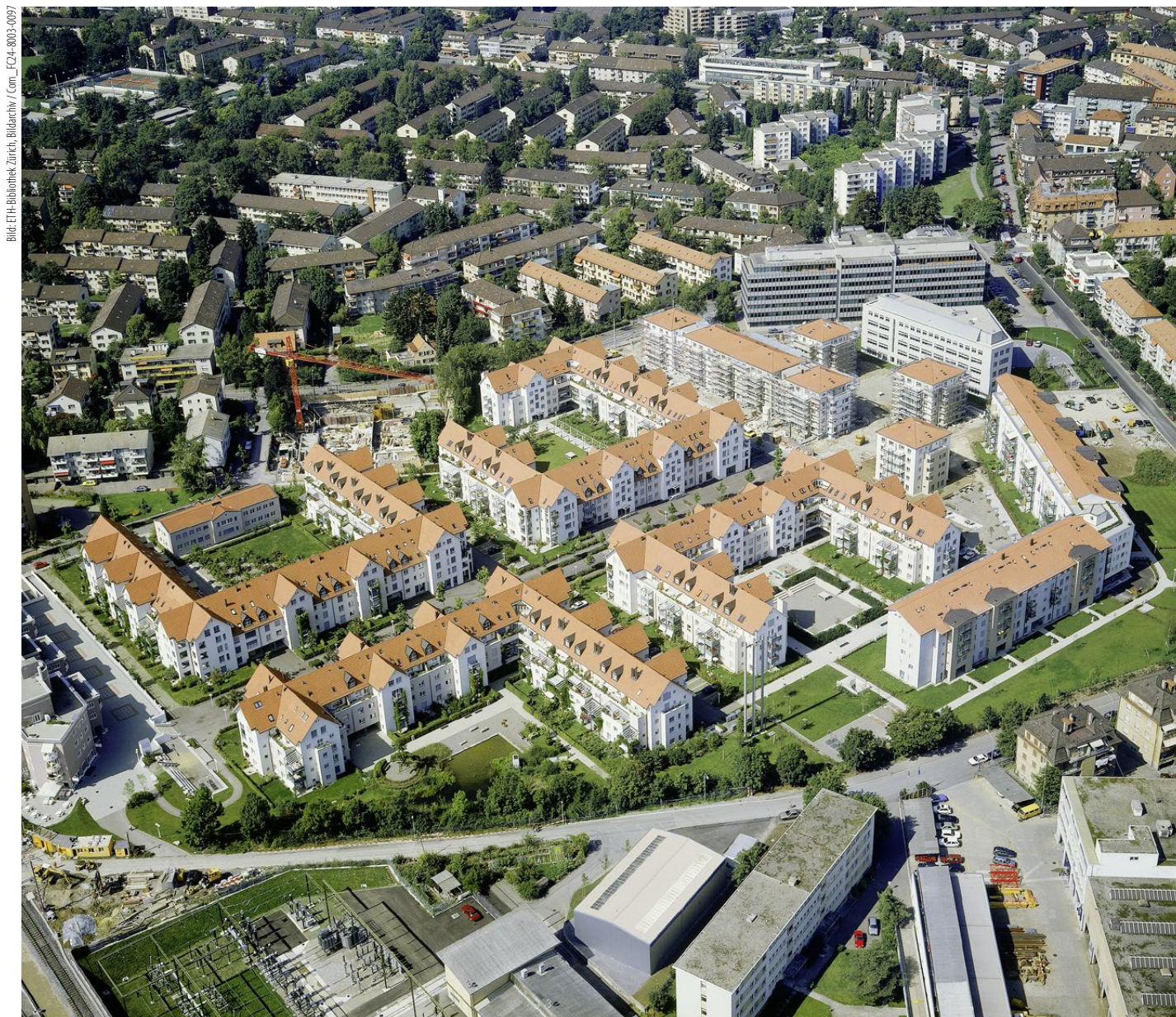
Das Tiergarten-Quartier im Jahre 1992. In das Quartier verirren sich nur selten Aussenstehende.
