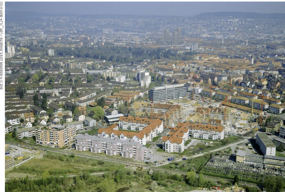
Die Siedlung Tiergarten während des Baus 1990. Bereits damals konnten erste Parteien einziehen.
