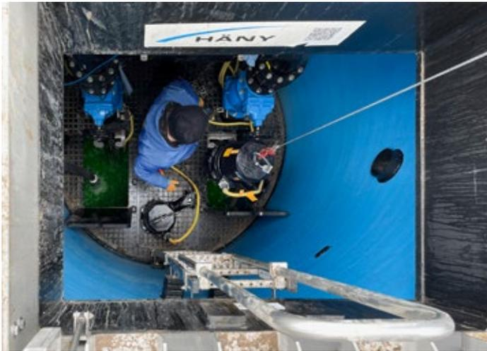
Ein Techniker montiert im Schacht die Pumpen.
