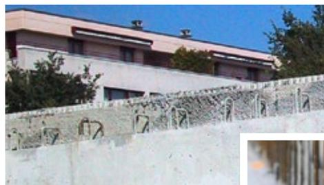
Die Bego Deckenrandabschalung ermöglicht es, die Decken-Stirnschalung und die Betonwand zeitgleich zu erstellen.
