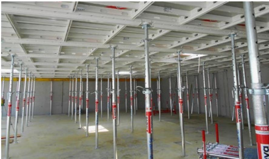
MevaDec ermöglicht sicheres, effizientes Schalen von unten und erfüllt die neuen Anforderungen der BauAV zur Absturz-sicherung.
