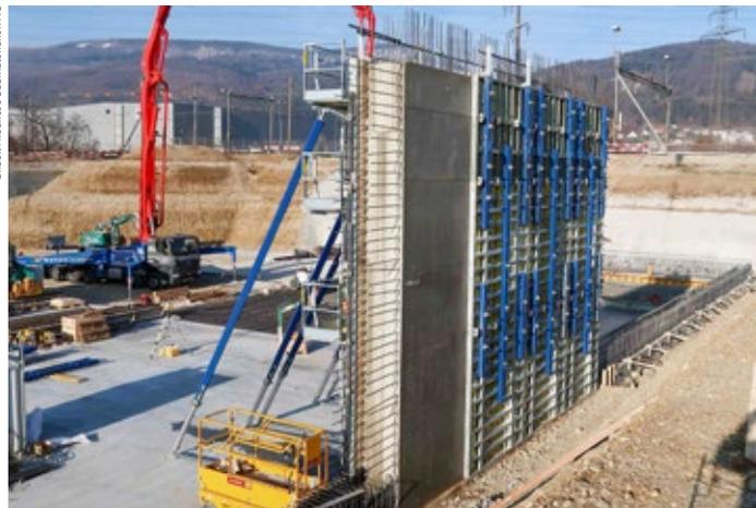
V-Max Board; Arbeitsfugenabschlusung mit Eisendurchdringung bei einer 10 Meter hohen Wand.
