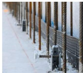
Wände ist die Deckenrandschalung bereits fertiggestellt – eine enorme Zeitersparnis. Das Bego-System macht alle Ausschal- und Reinigungsarbeiten überflüssig und ist zudem mit integrierten Anker-Hülsen oder Aussparungen für Konsolen erhältlich. Darin können Abstellungen oder Konsolen für die Abstellung von Wandschalungen der oberen Etagen verankert werden.
