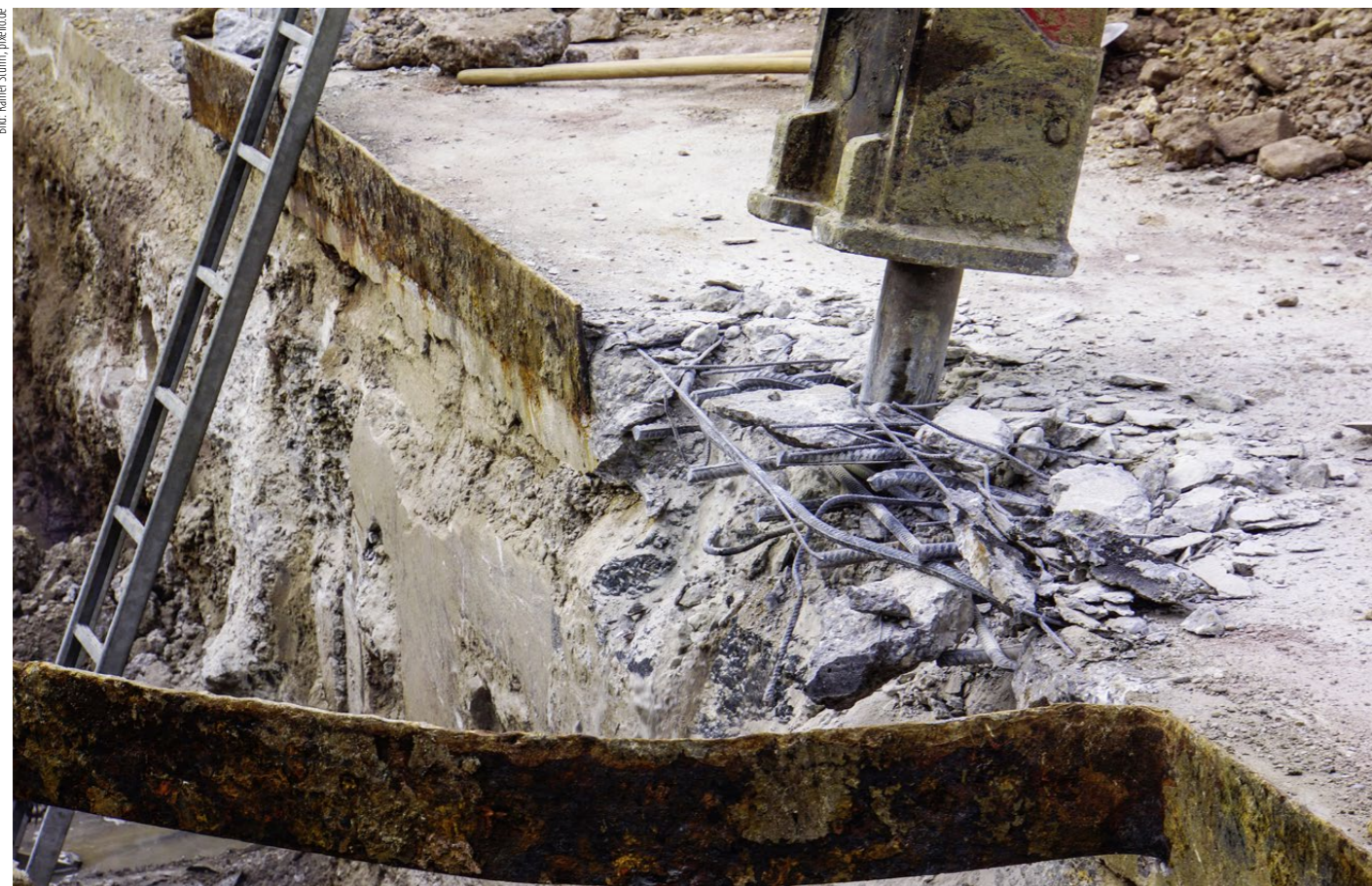
Selbst die stärksten Strukturen fallen Korrosion zum Opfer: Metalle wie etwa Stahl reagieren mit Sauerstoff und Wasser, rosten und zerfallen.
