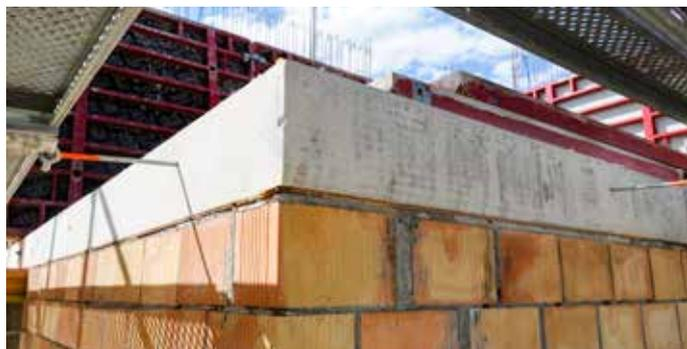
BEGO-System, mit dem die Betonwand und die Deckenrandabschalung in einem einzigen Schritt erstellt werden können. Dadurch entfällt das Ausschalen komplett.
