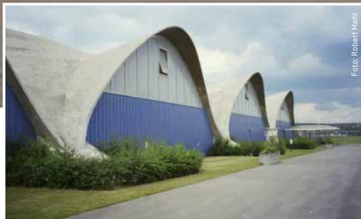
Zentimeter «dünn» und «verdickten» sich in Richtung Stützen dann wieder auf fünfzehn Zentimeter. Jede dieser gemäss Mario Botta «fragilen» Umhüllungen waren fast fünfzig Meter lang und zwanzig Meter breit – also riesig.
