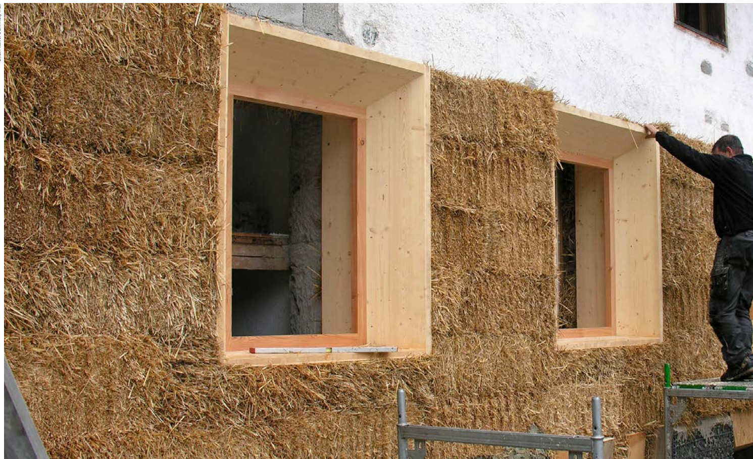
Baustoffe aus nachwachsenden Rohstoffen verursachen deutlich weniger Treibhausgasemissionen. Dieses Foto zeigt das Projekt «Haus P & W» oder «Casa Steila Mar» in Susch, bei dem die Aussenfassade mit Stroh thermisch saniert wurde.
