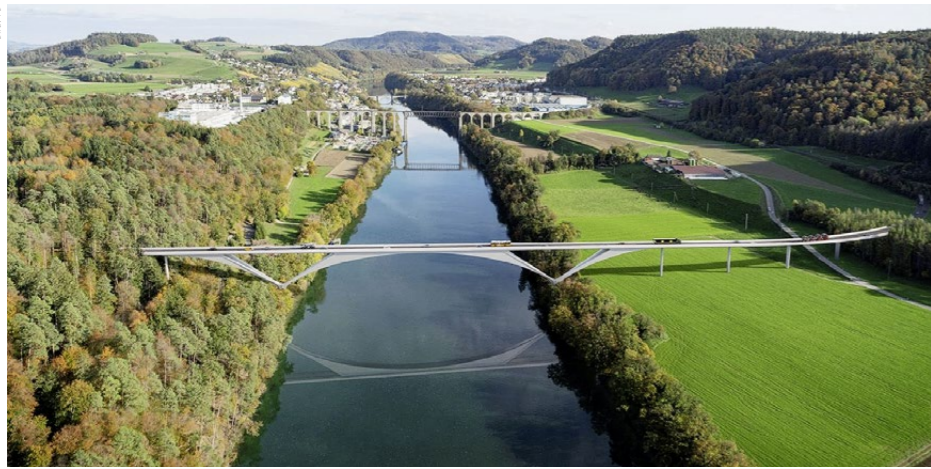
Ein Hingucker: So wird die neue Calatrava-Brücke aussehen, die das Kernstück der Ortsumfahrung Eglisau bildet.
