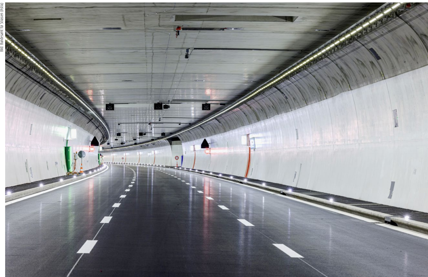
Die dritte Röhre des chronisch überlasteten Gubrist-Tunnels ist eröffnet. Nun müssen aber die Röhren eins und zwei saniert werden.
