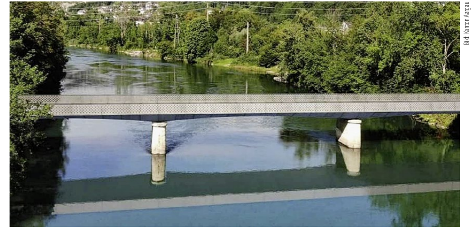
Neue Aarebrücke bei Möriken-Wildegg: Ultrahochfester Faserbeton soll eine Lebensdauer von hundert Jahren garantieren.
