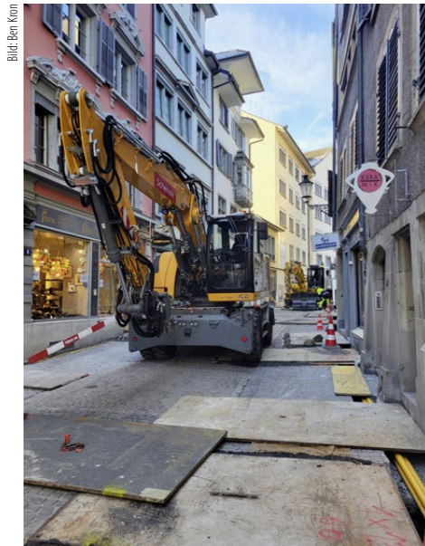
Leitungsbau im Zürcher Niederdorf: Die Arbeiten ziehen sich noch bis ins Jahr 2028 hin.
