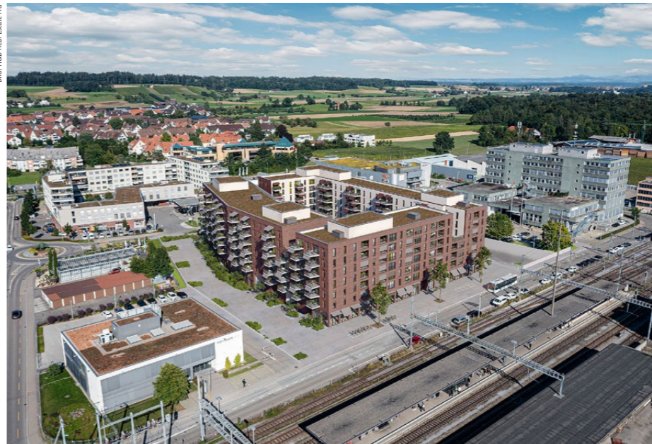
Überbauung «Rägipark» in Regensdorf: In mehreren Städten rund um die Metropole Zürich entstehen grosse Wohnüberbauungen.
