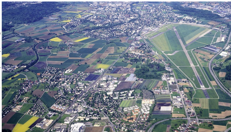
Flughafen Dübendorf: Die Umwandlung in einen Innovationspark ist einen wichtigen planerischen Schritt weitergekommen.
