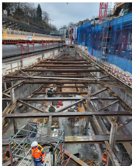
Baustelle des «Haus zum Falken» in Zürich-Stadelhofen: Der Calatrava-Bau kommt direkt neben dem Calatrava-Bahnhof zu stehen.
