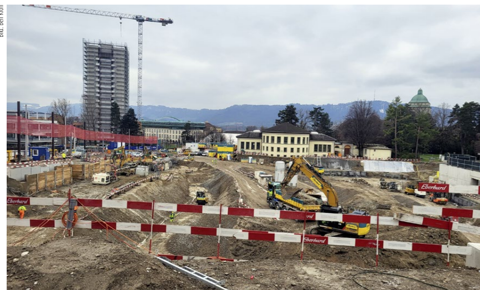
Baugrube fürs neue Universitätsspital Zürich: Insgesamt werden für die verschiedenen Projekte zwei Milliarden Franken investiert.
