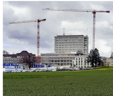
Bauarbeiten am Spital Wetzikon: Im Kanton Zürich sind eine ganze Reihe von Spitalprojekten im Gange.
