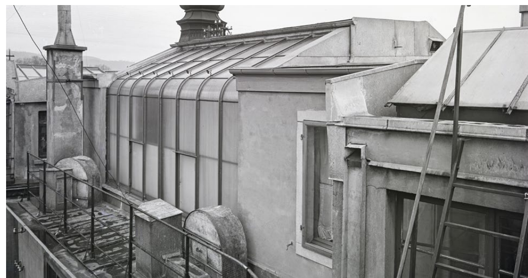
Meiners Atelier nach dem Umbau.
