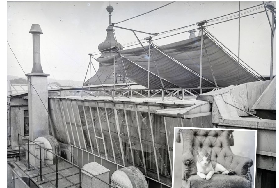
Eine abenteuerliche Konstruktion: Johannes Meiners Atelier vor dem Umbau um 1909 – mit Sonnensegel.
