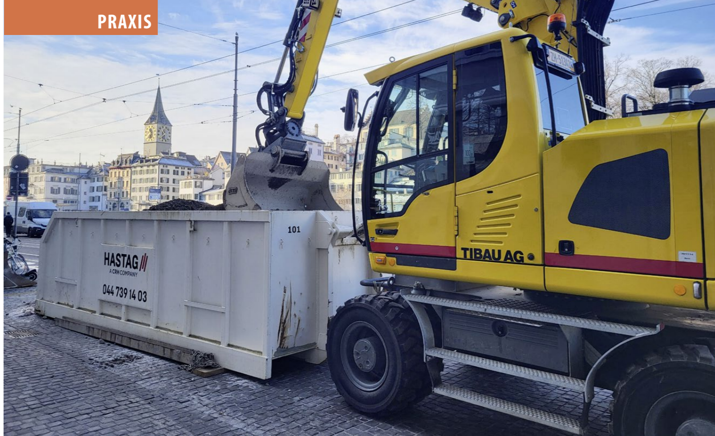
Baggern vor malerischer Kulisse: Der Platz für jeden Container musste in der Planung ermittelt werden.
