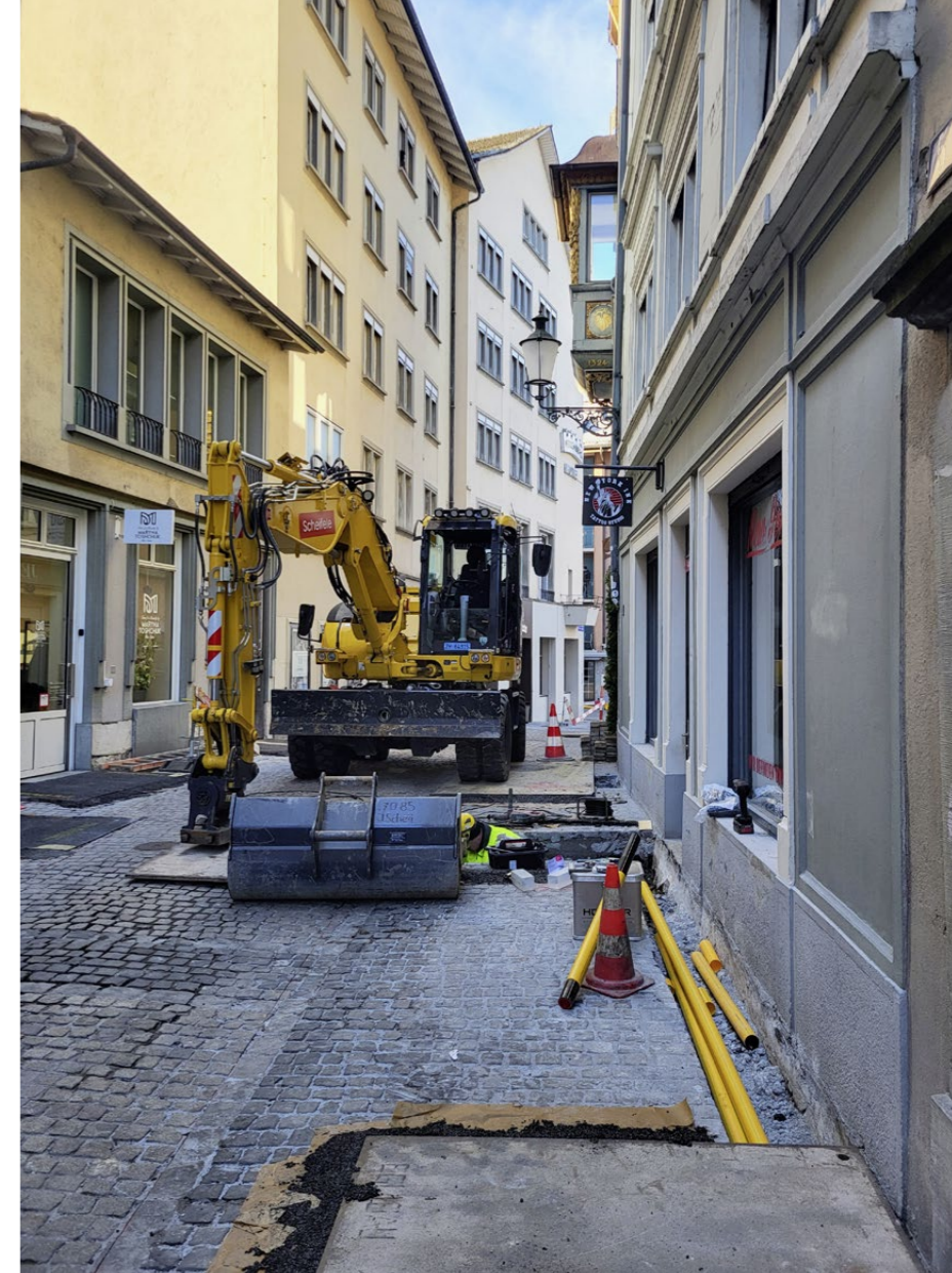
Maschineneinsatz zwischen mittelalterlichen Häusern: Während der Sommermonate ruhen die Arbeiten im Nieder- und Oberdorf in den Hauptgassen.
