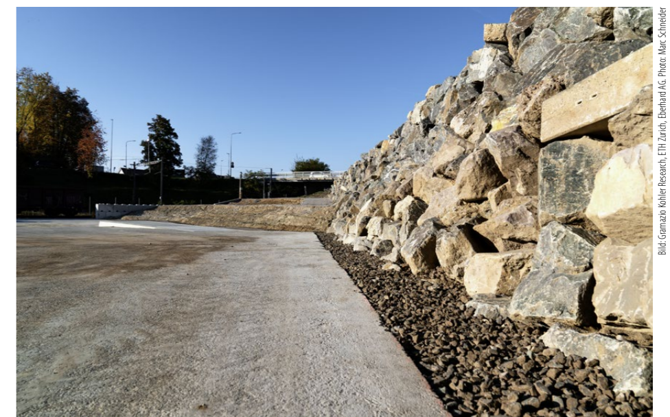
Für den Bau der Trockenmauer wurden recycelter Beton und Steine aus der Region verwendet. Zudem wurden verschiedene ökologische Materialien in den Bau des Demonstrationsobjekts integriert. Der Drainagekies in der Aufschüttung wurde so etwa aus Eisenbahnschotter recycelt.
