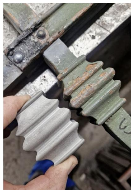
Der Vergleich zeigt die alte und die neu produzierte Geländermanschette, einer millimetergenauen Kopie des originalen Teils.
