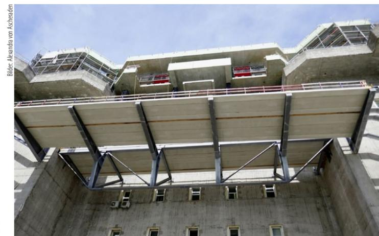
Der Bergpfad ruht auf 24 Stahltragarmen. Jeder einzelne wiegt etwa 5,5 Tonnen und ist mit Gewindestangen in der Aussenwand verankert.
