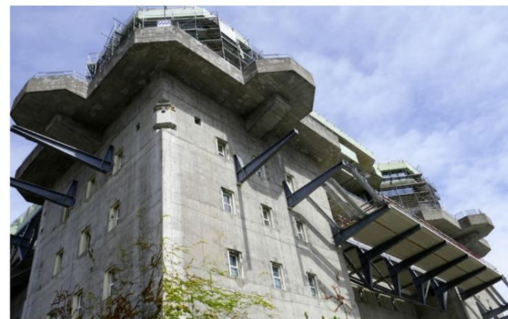
Zwischenstadium vom August 2022: Fünf neue Stockwerke werden pyramidenartig auf das Mahnmahl aus dem Zweiten Weltkrieg aufgesetzt.
