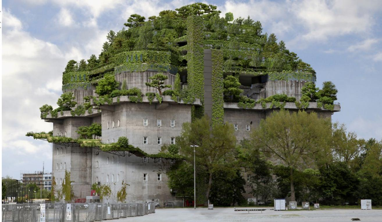
ruht auf insgesamt 24 Stahltragarmen. Jeder einzelne wiegt etwa 5,5 Tonnen und ist mit zwei bis drei Meter langen Gewindestangen in der massiven Aussenwand verankert. Die Stahltragarme tragen die etwa zwanzig Zentimeter dicken Spannbetonplatten, auf die nochmals etwa gleich viel
