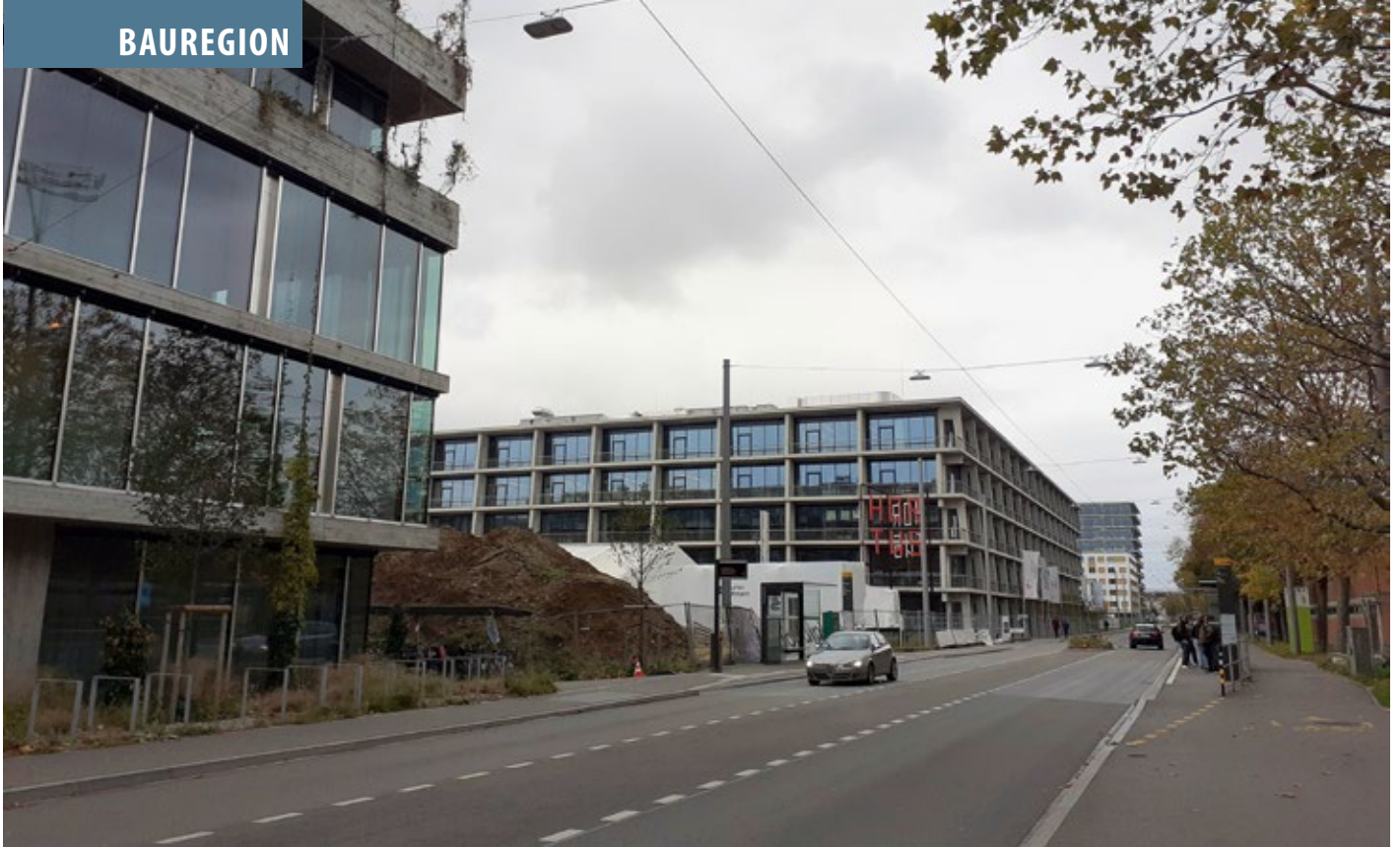
Das Allschwiler Bachgraben-Areal wird zum Zentrum für Medizin und Biotechnologie: 3000 Personen finden Platz im neu eröffneten Campus-Gebäude. Auf dem Bild links im Vordergrund der Bau des Tropeninstituts der Uni Basel.
