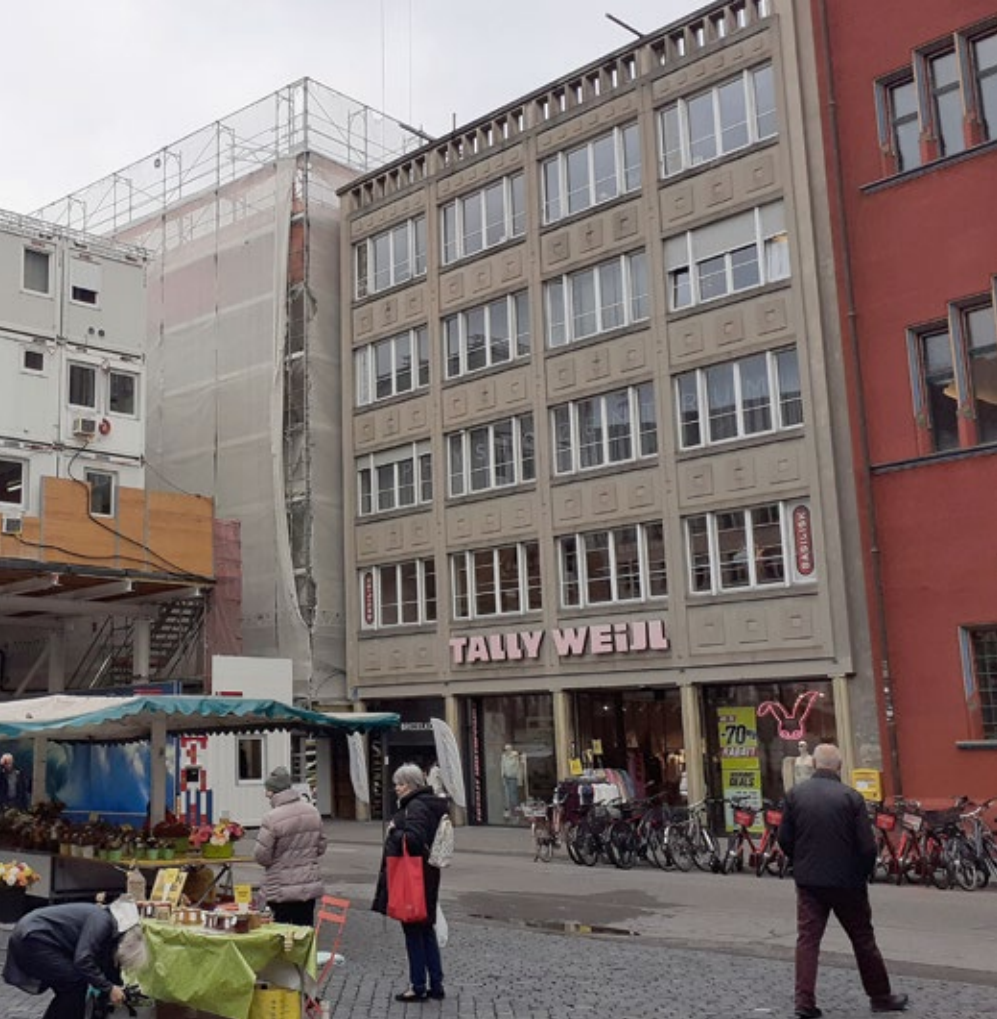
Kaufhaus Globus am Basler Marktplatz wird von Grund auf neu gebaut.
