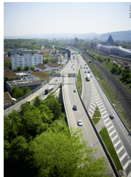
Die Nord-Süd-Hauptverkehrsachse A2 Osttangente Basel ist eine der am stärksten befahrenen Autobahnen der Schweiz.
