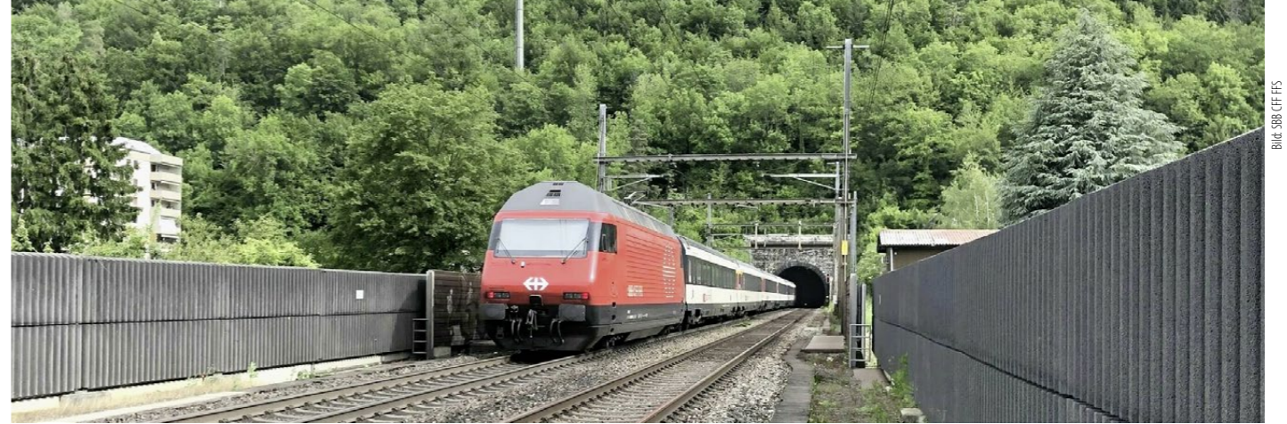
Südportal des Hauenstein-Basistunnels zwischen Tecknau BL und Trimbach SO: Der Baustart für die geplante Sanierung wird auf den Herbst 2023 verschoben.
