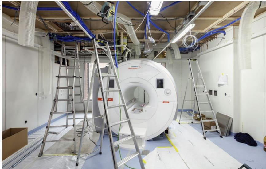
Einbau eines Magnetresonanz-Tomographen: BIM erlaubte den Fachplanern, auch solch komplexe Installationen kollisionsfrei zu bewältigen.
