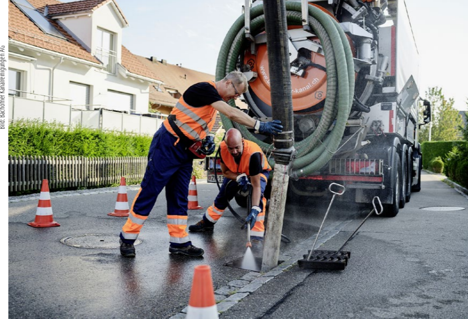
Das Aufgabengebiet der Bachofner Kanalreinigungen AG umfasst unter anderem Spül- und Saugarbeiten von Kanalrohren. Mitarbeiter mit und ohne Handicap arbeiten dafür im Team zusammen.
