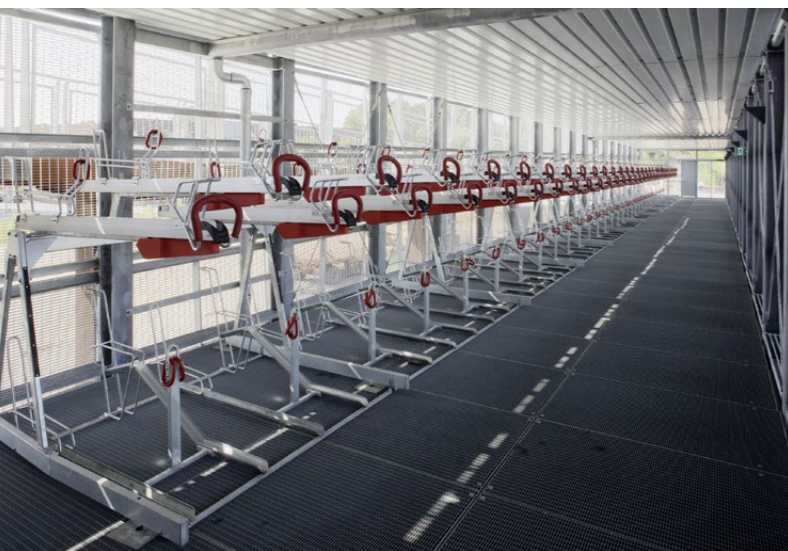
Blick ins erste Obergeschoss: Der Boden besteht aus Gitterrosten; Wasser fällt in die Trapezbleche darunter und wird abgeführt. Die Trapezbleche bilden gleichzeitig die Decken (obere Bildhälfte).
